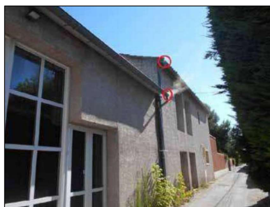
Figure 4 : Exemples d'anomalies décelées lors des tests à la fumée
