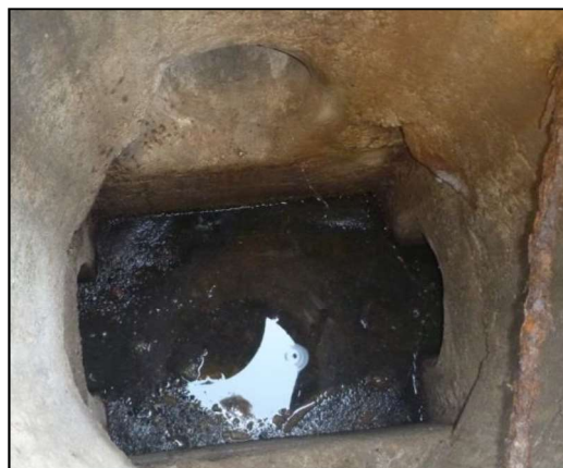
Figure 15 : Exemple de DO en canalisation
