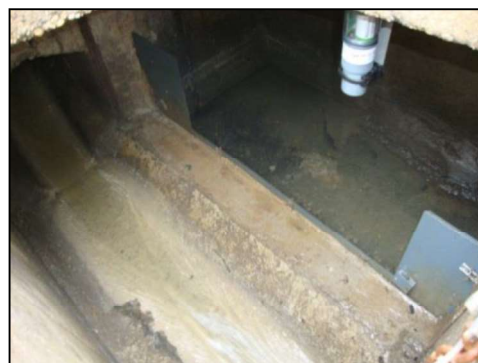
Figure 14 : Exemple de lame déversante
