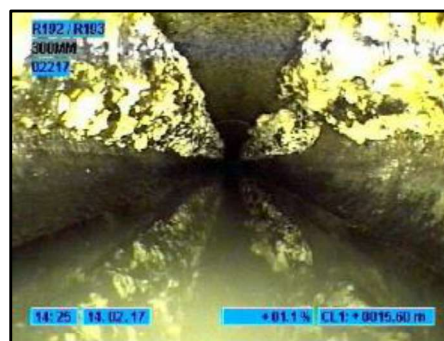
Figure 9 : Photographie de dépôts de graisses (AXIS 3D 2017)
