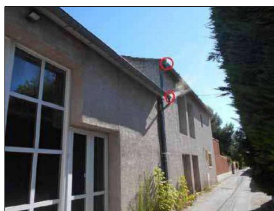
Figure 3 : Exemples d'anomalies décelées lors des tests à la fumée
