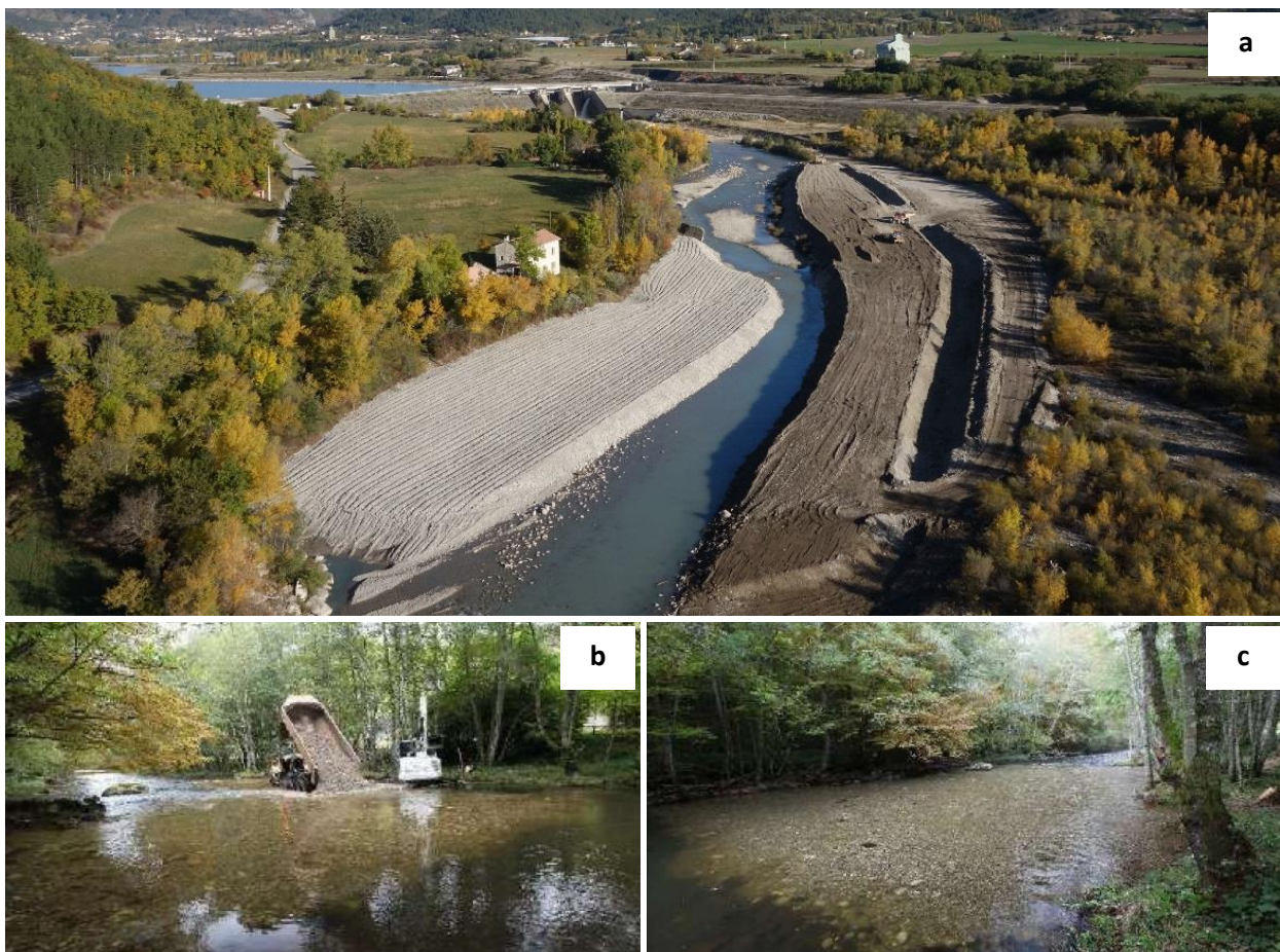
Figure 2. Exemples d'injections sédimentaires : a) sur le Buëch en aval du barrage de Saint-Sauveur (EDF) ; b&c) sur la Maronne en aval du barrage de Hautefage (Ecogea 2017)
