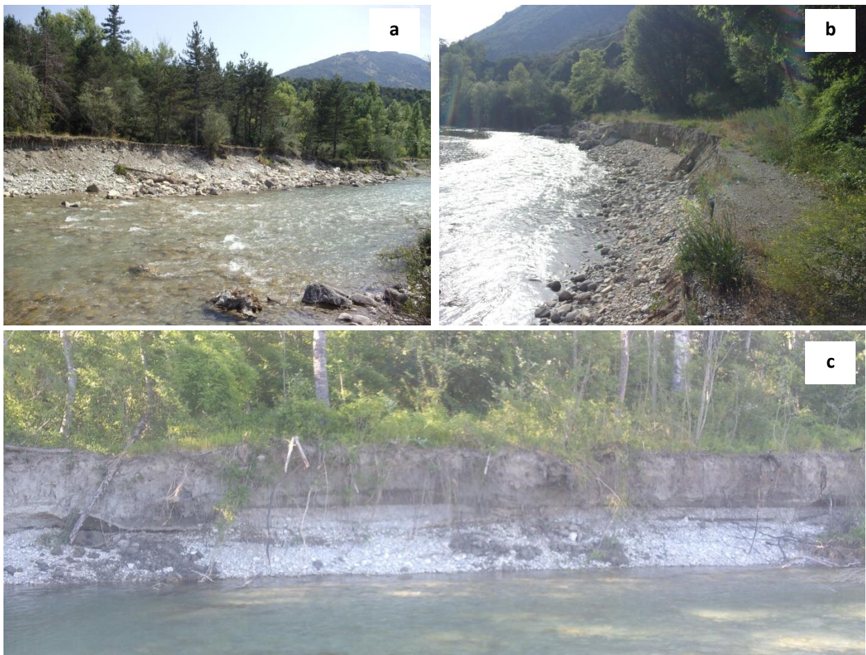
Figure 27. Exemples d'érosions de berge du Moyen Verdon : a) érosion de la rive gauche en amont du ruisseau du Pesquier, dans la traversée centre de Castellane ; b), érosion de la rive droite en aval du camping de la Salaou ; c) érosion de la rive droite en amont du Jabron
