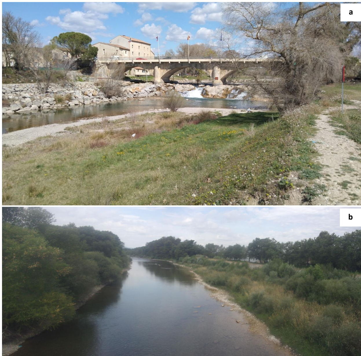
Figure 9. Site d'injection n°3 : en aval immédiat du pont de Vinon (a) et en aval de la passerelle piétonne (b)
