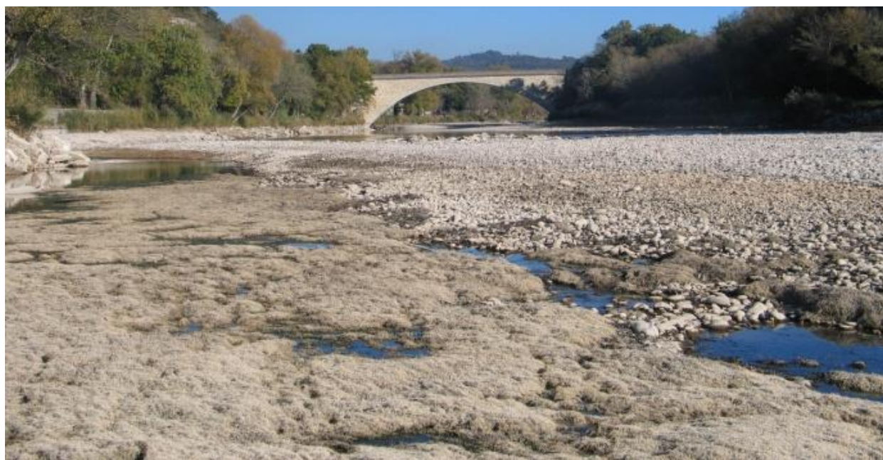
Figure 21. Fonds de la retenue de Gréoux lors d'une vidange en 2004 (source : PNRV, d'après Artelia 2015)
