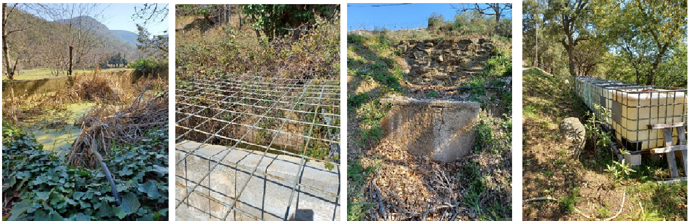
Figure 4 - Exemples de bâches de stockage de l'eau brute
