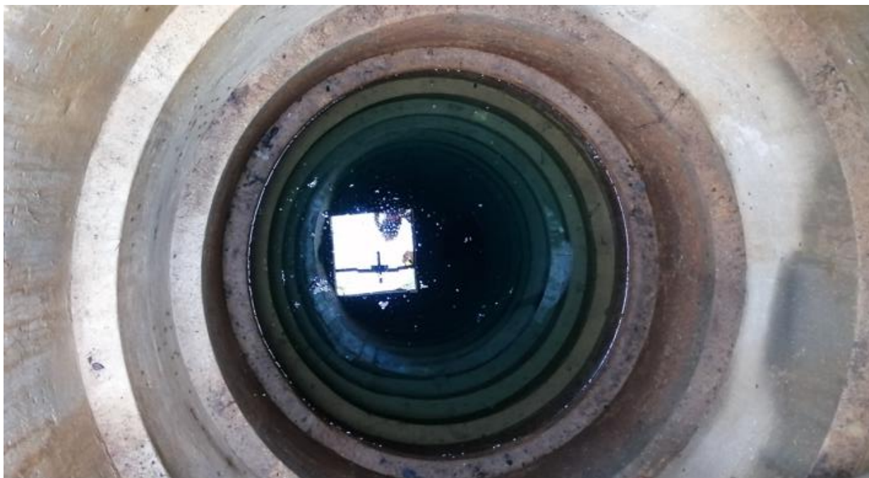
Figure 6 : Intérieur du puits des Harkis
