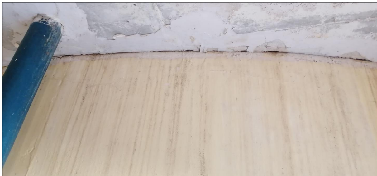
Figure 23 : Génie civil de la chambre de vannes
