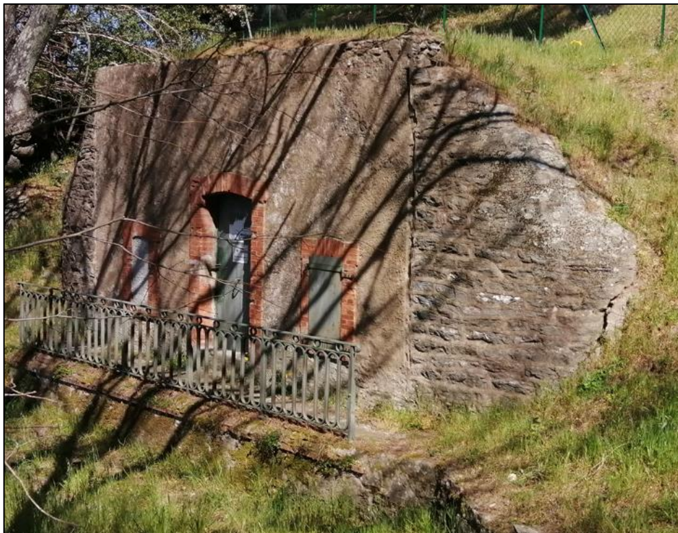
Figure 20 : Réservoir Camping 600 m 3
