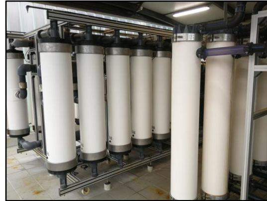
Figure 18 : Principe et exemple d'ultrafiltration
