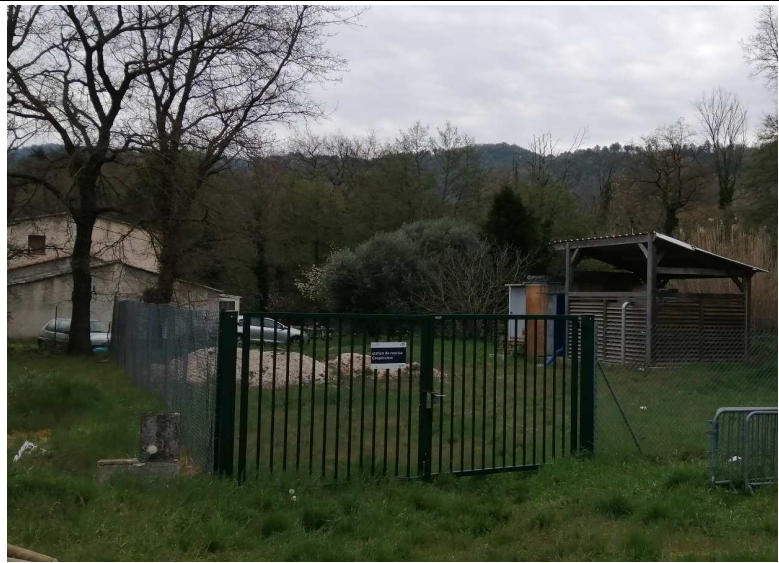
Vue extérieure de la station
