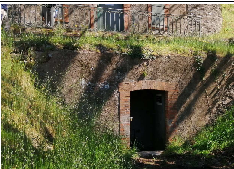
Vue extérieure du réservoir (600 m³)
