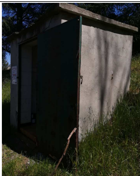
Vue extérieure local chloration
