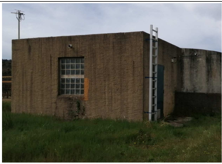
Vue extérieure de la station
