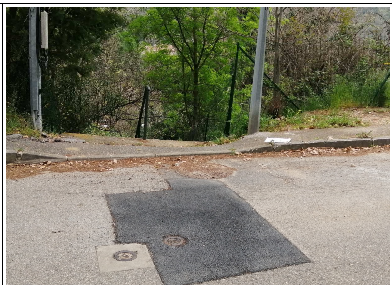
Vanne de régulation amont
