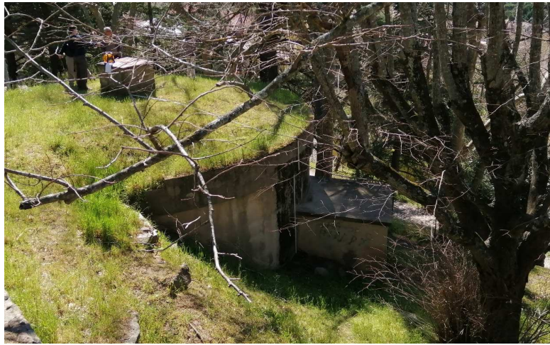
Vue extérieure du réservoir (300 m³)
