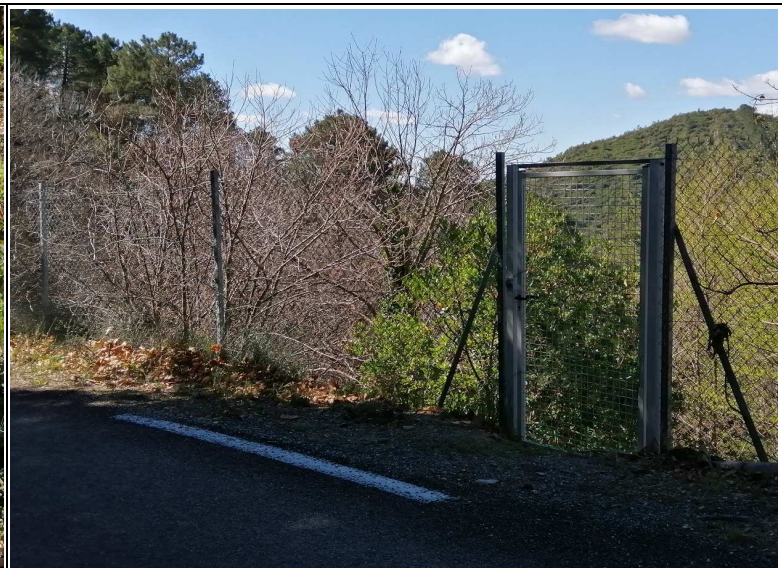
Portail d'accès au périmètre de protection
