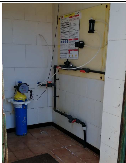
Vue intérieure local chloration
