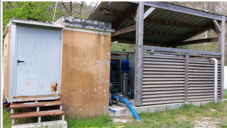
Vue extérieure de la station
