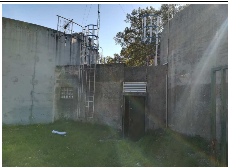
Vue extérieure du réservoir
