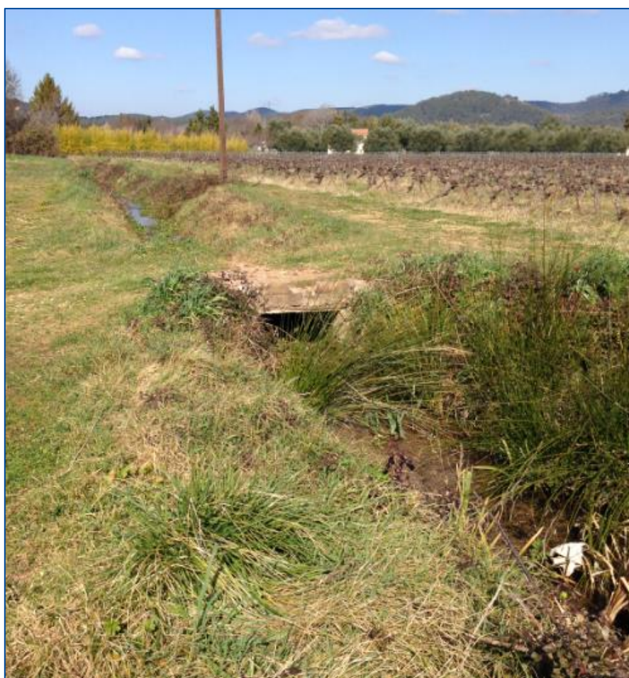
Figure 11 Ouvrage hydraulique sur un arrosant
