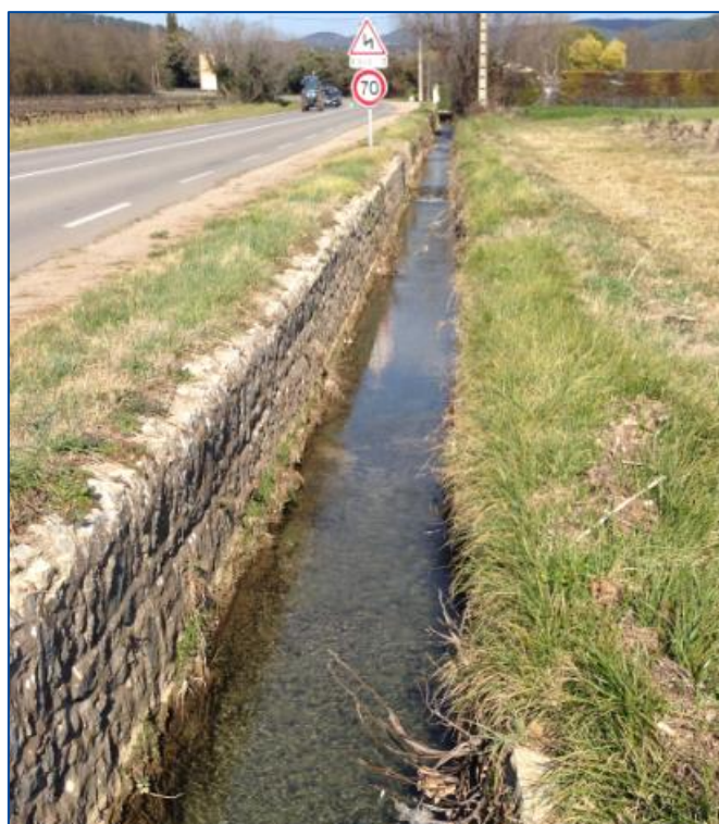
Figure 13 Tronçon du Soliès en aval du centre-ville
