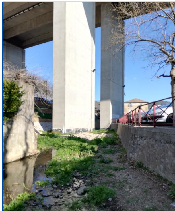
Figure 5 Piles du pont de l'A8 en travers du lit mineur - Soliès
