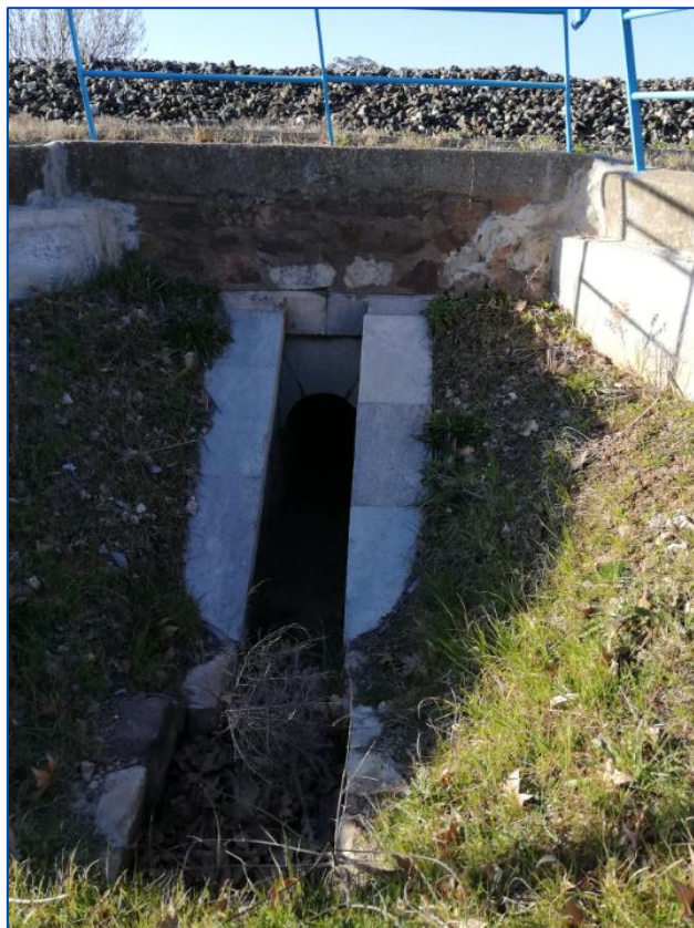
Figure 15 Ouvrage de transparence pour passage de la voie ferrée
