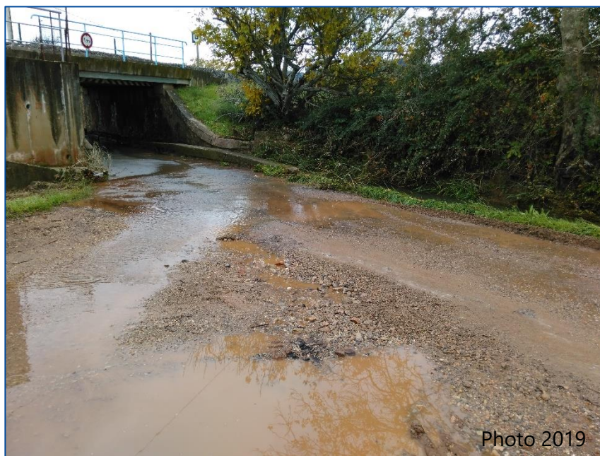
Figure 16 Pont de Saint Jean et point de cumul des écoulements
