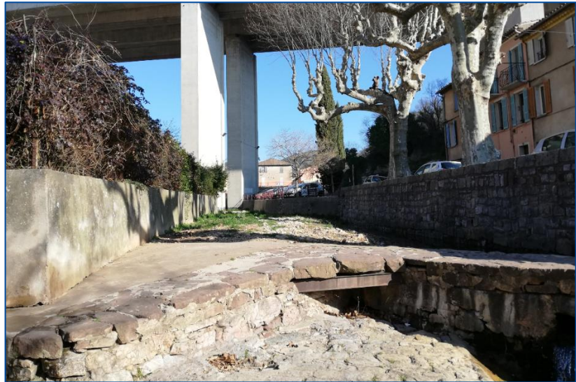
Figure 6 Seuil en aval du pont de l'A8
