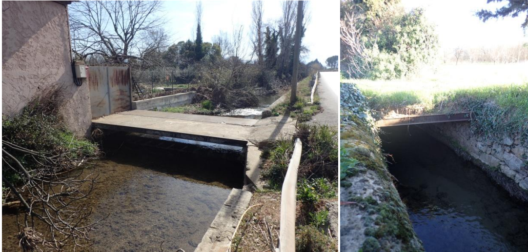
Figure 31. Ouvrages de franchissement sur le tronçon Soliès 7. Source : Morph'eau Conseils, 2019.
