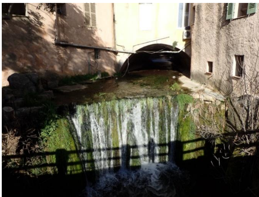
Figure 48. Seuil (COU_SE_4) sur le Coudounier. Source : Morph'eau Conseils, 2019.
