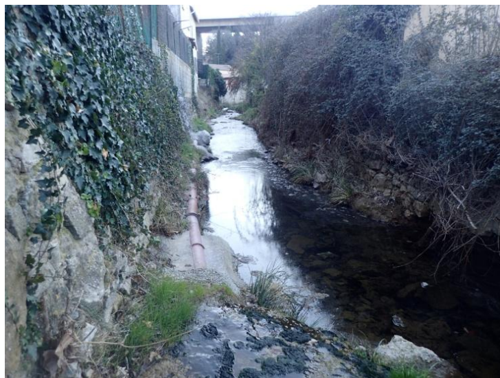
Figure 22. Seuil au PK 4,6. Source : Morph'eau Conseils, 2019.
