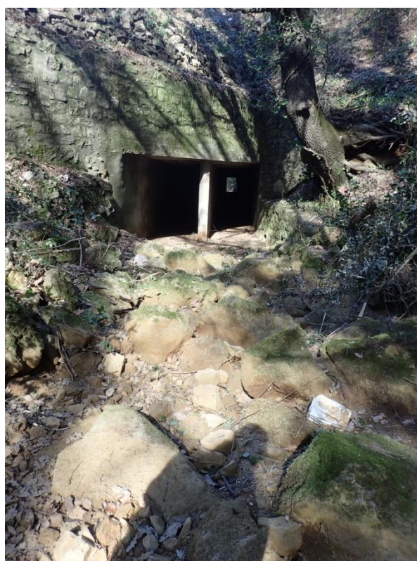
Figure 42. Ouvrage de franchissement de la route DN 7 sur le tronçon Coudounier 4 (vue amont). Source : Morph'eau Conseils, 2019.
