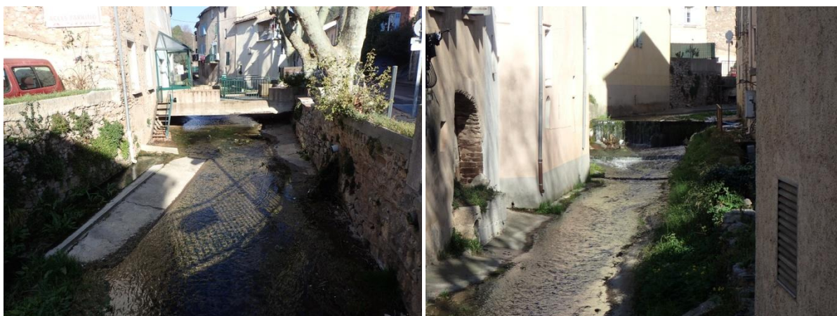
Figure 47. Aménagements du Coudounier dans la traversée du centre bourg du Luc.
