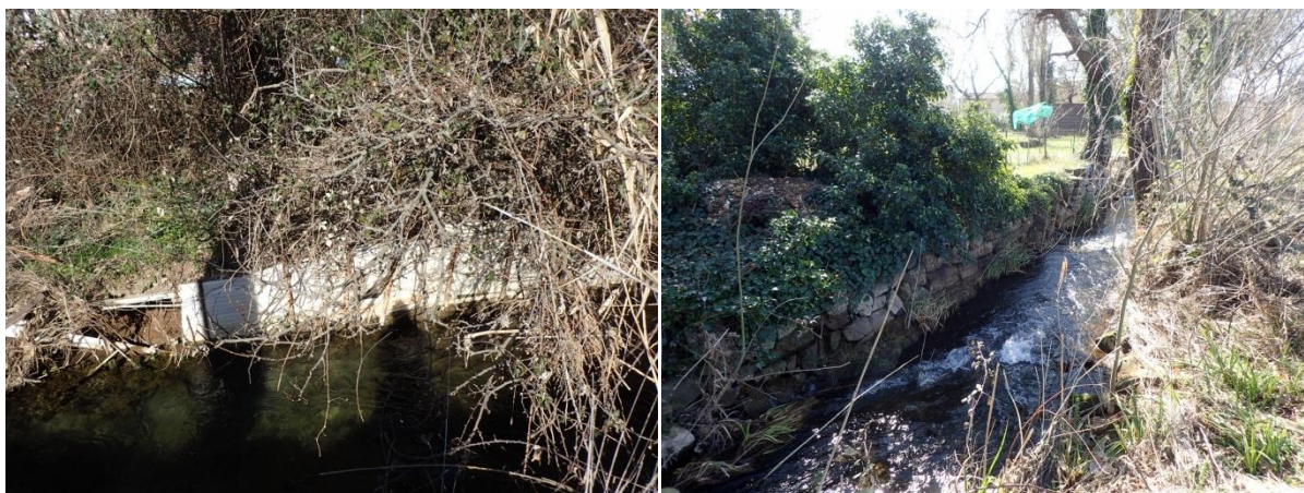
Figure 33. Protections de berge sur le tronçon Soliès 8. Source : Morph'eau Conseils, 2019.
