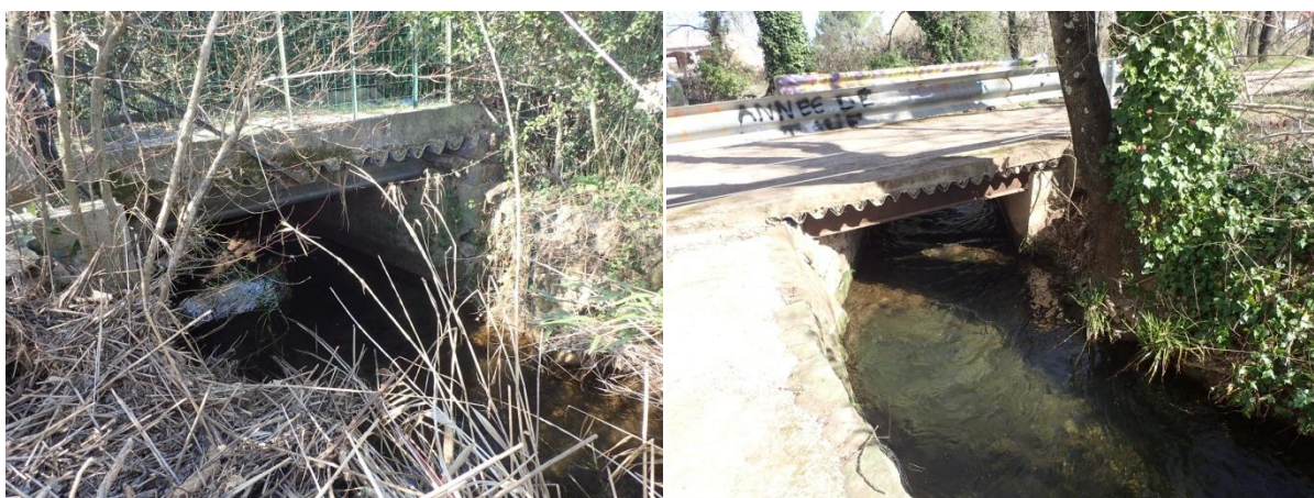
Figure 34. Ouvrages transversaux, à faible capacité hydraulique sur le tronçon Soliès 8. Source : Morph'eau Conseils, 2019.
