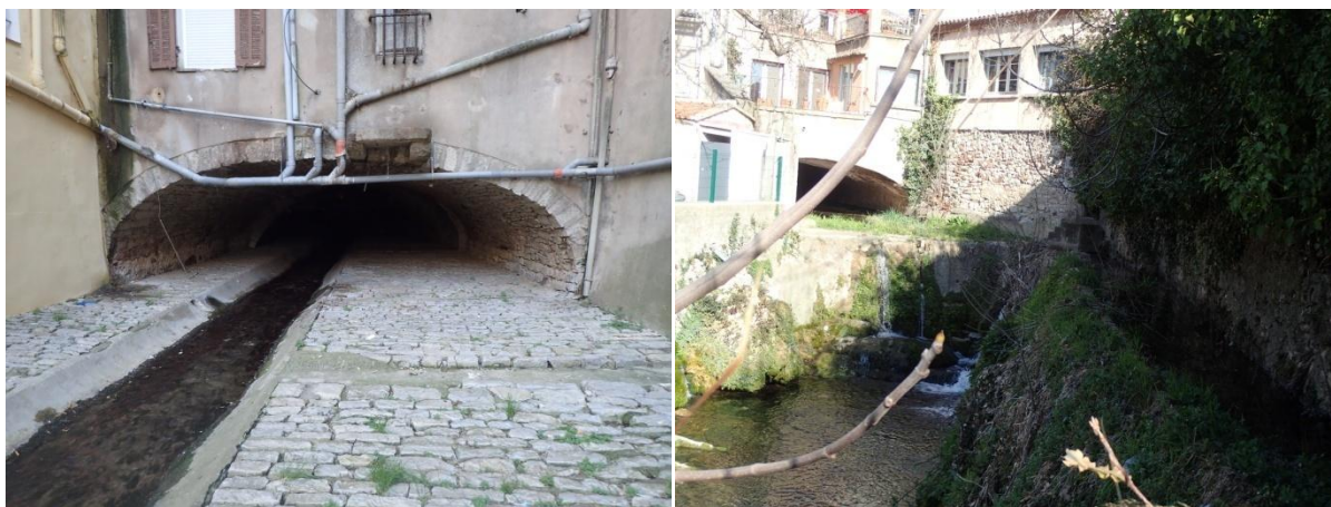
Figure 25. Vue amont du passage souterrain (à gauche) et vue aval et seuil en sortie du passage souterrain (à droite). Source : Morph'eau Conseils, 2019.
