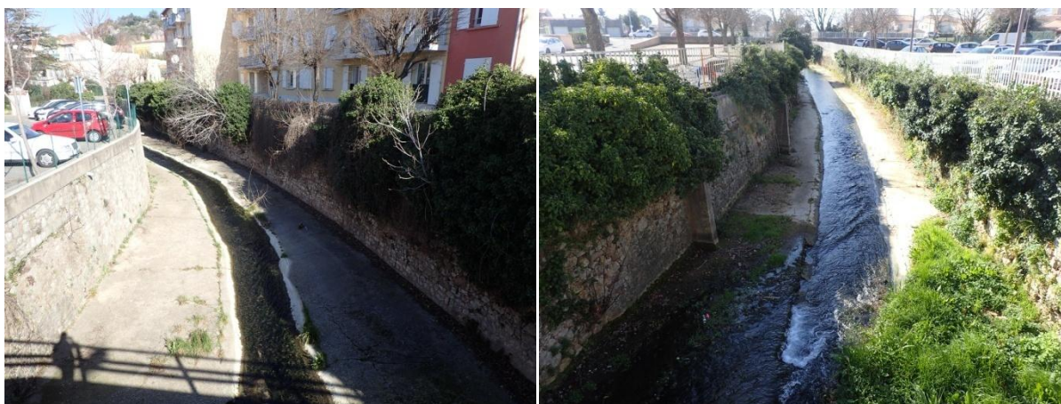
Figure 26. Lit du Soliès aménagé en cunette béton sur le tronçon 5. Source : Morph'eau Conseils, 2019.
