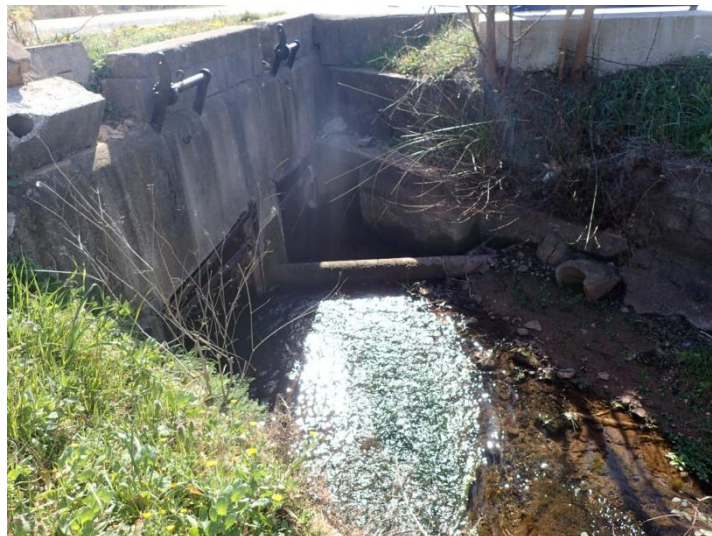
Figure 50. Vue amont de l'ouvrage de franchissement de la route D97 sur le Riautort. Source : Morph'eau Conseils, 2019.
