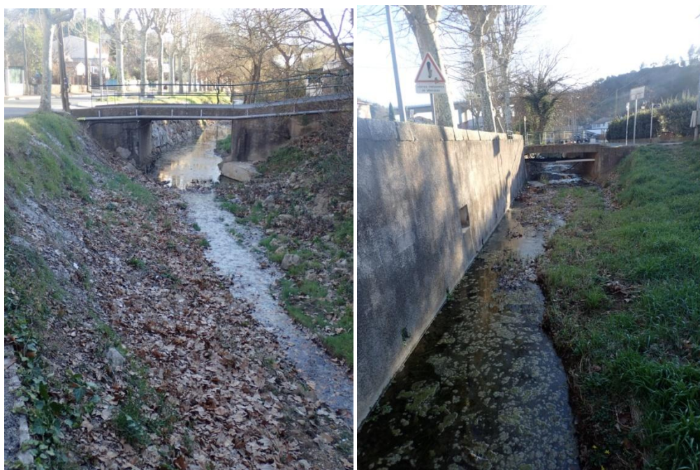
Figure 20. Différents ouvrages de franchissement sur le tronçon Soliès 3 dont les capacités hydrauliques sont insuffisantes. Source : Morph'eau Conseils, 2019.
