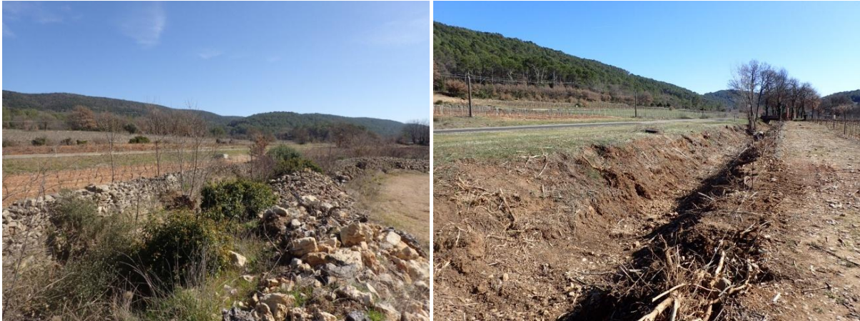
Figure 17. Lit canalisé par les merlons (à gauche) ou fortement entretenu (curage / coupe de la végétation à blanc) le long de la RD 33 (à droite)
