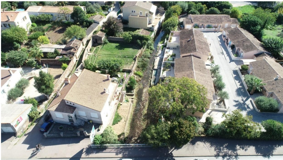
Figure 27. Aménagements diminuant la section d'écoulement à l'amont du tronçon 6. Source : SMA, 2019.
