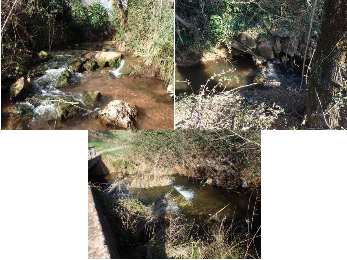
Figure 54. Seuils sur le tronçon Riautort 2. Source : Morph'eau Conseils, 2019.
