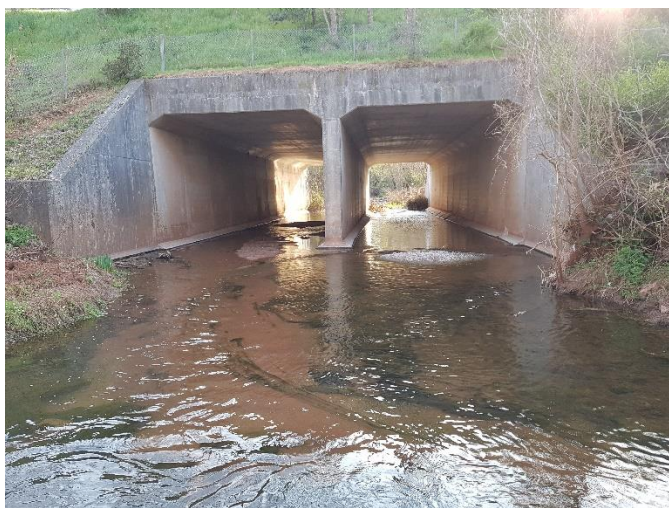
Le Riautort en amont du passage sous l'autoroute (février 2020)
