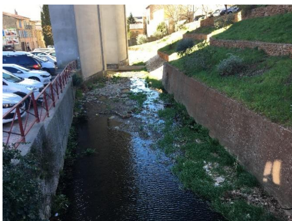
Le Soliès sous le viaduc de l'A8 dans Le Luc (février 2020)
