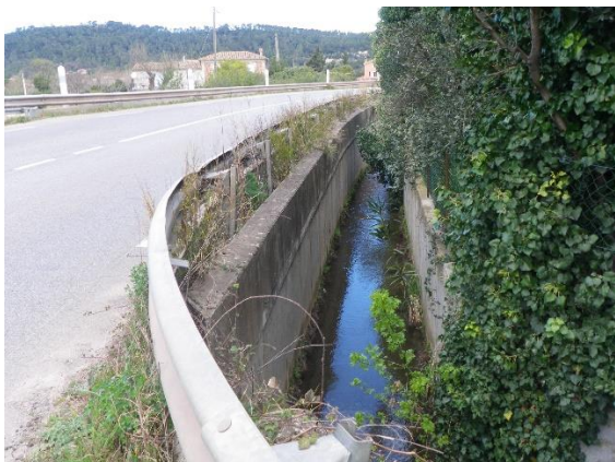
Le Soliès Ouest canalisé (mai 2019)
