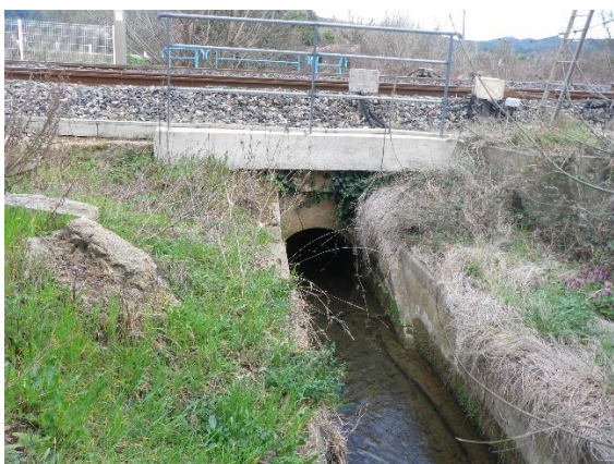
Passage sous la voie ferrée (mai 2019)
