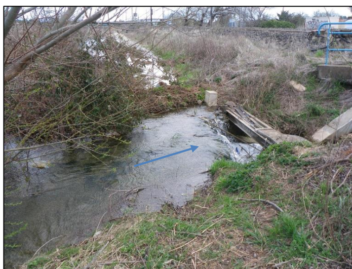
Figure 14 : Passage du Soliès sous la voie ferrée (code SOL-SE-20)
