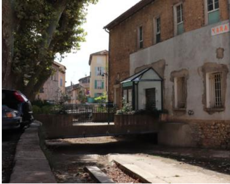
Figure 14 : Vue du site depuis l'amont
