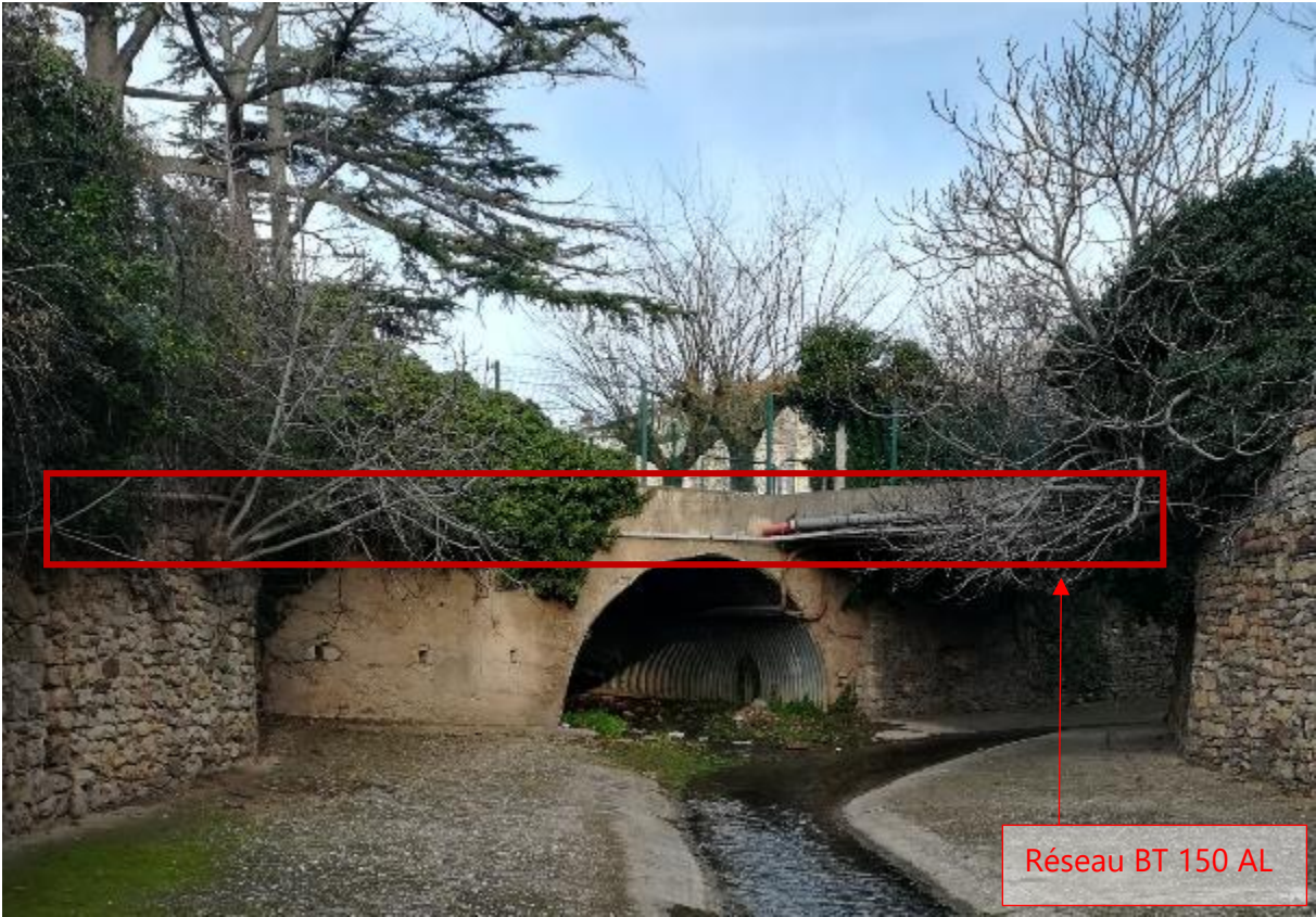
Figure 35 : Photo réseau ENEDIS - AM5
