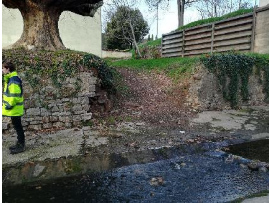
Figure 34 : Accès au droit du platane centenaire
