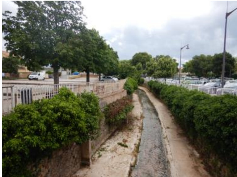
Figure 25 : Vue vers l'aval du pont reliant la rue pierre Gaudin au bouldrome
