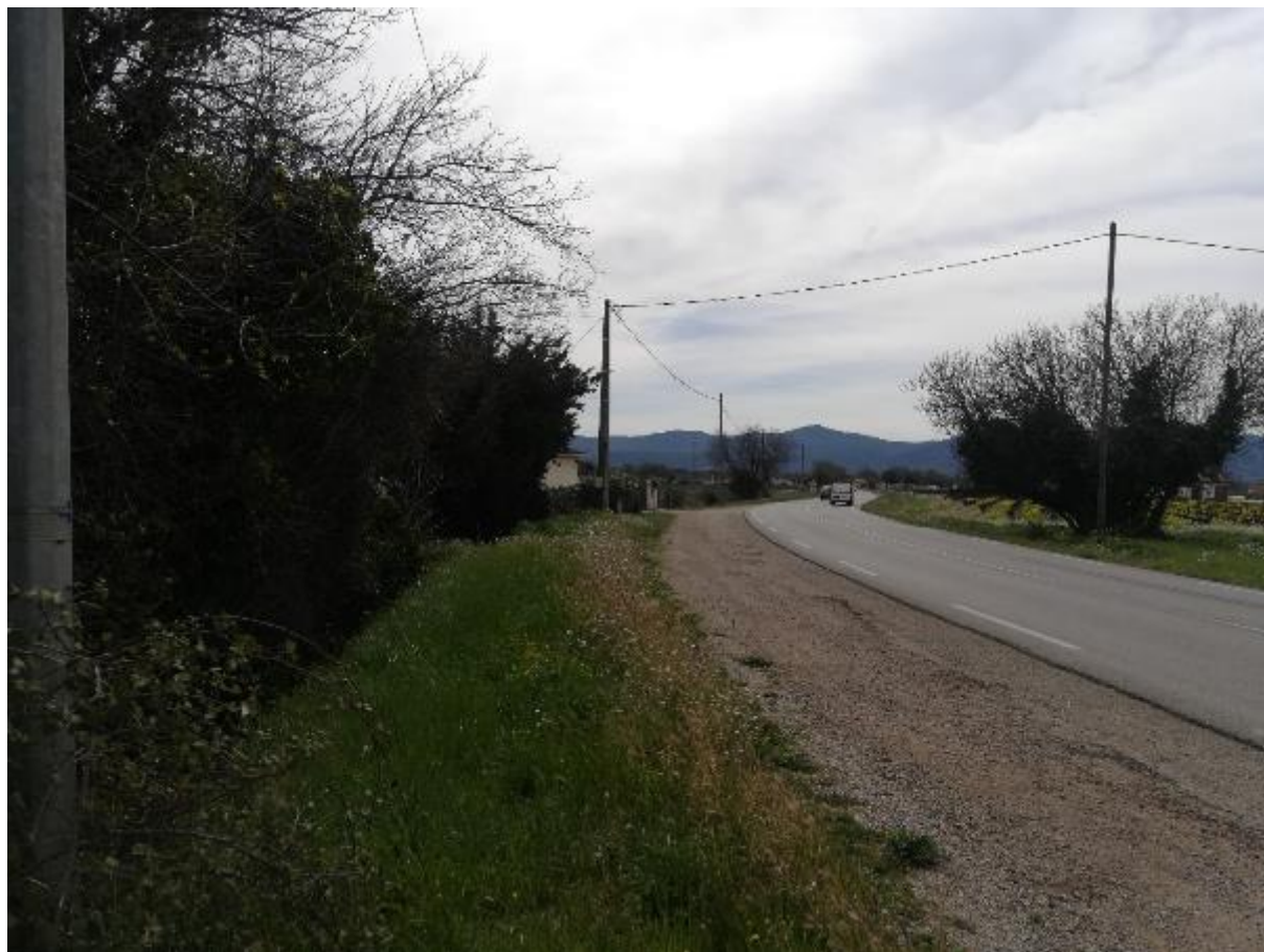
Figure 38 : Début de l'aménagement AM6, vue vers l'aval
