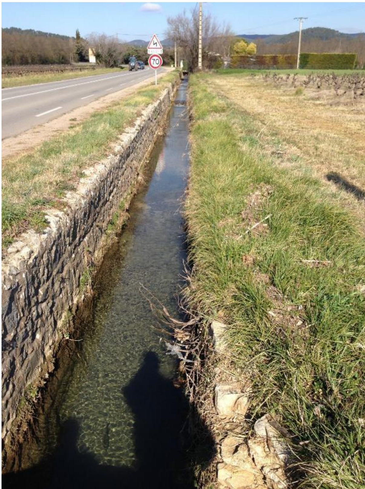
Figure 39 : Secteur en murs maçonnés en rive droite et en rive gauche, vue vers l'amont
