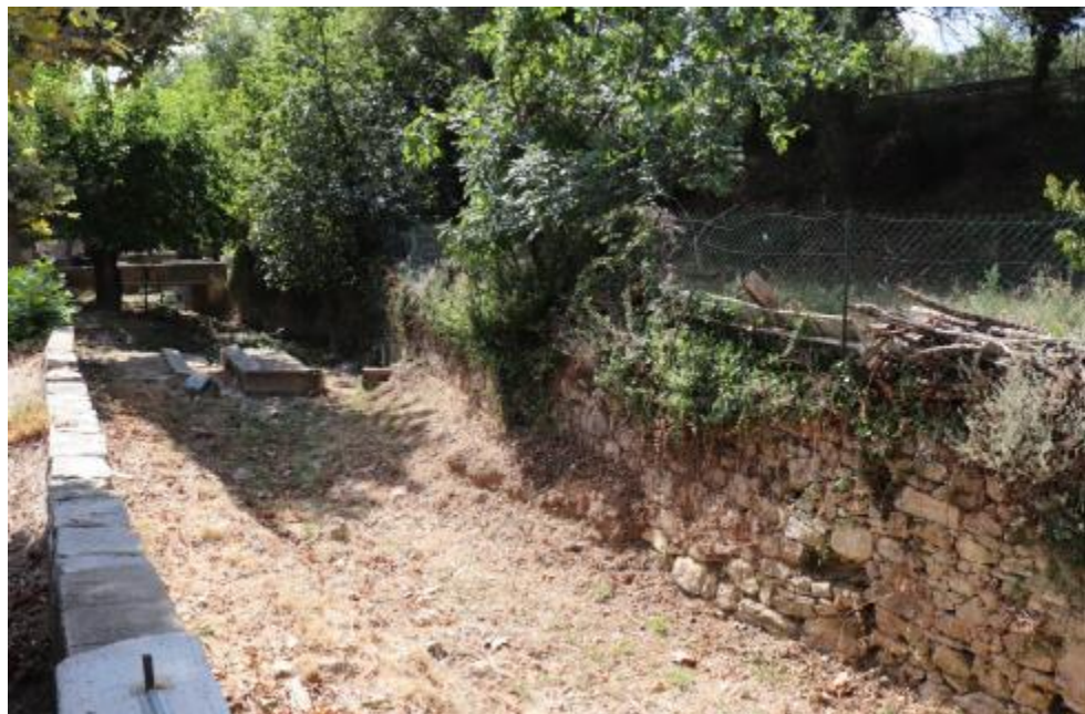
Figure 4 : vue du site depuis l'amont
