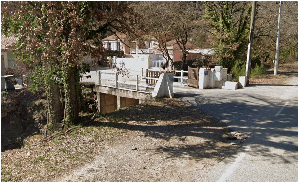
Figure 64 : double dalot situé en amont du site
