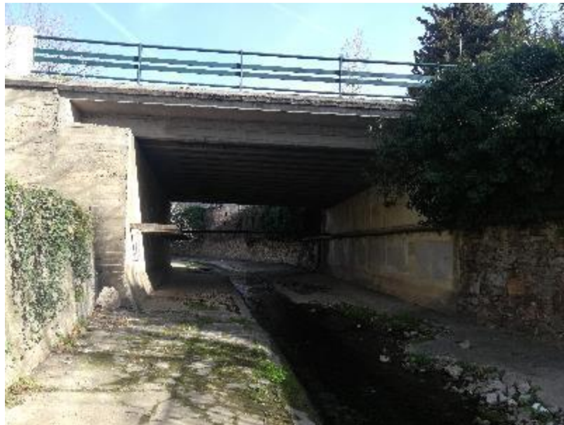
Figure 26 : Vue vers l'amont en aval du pont DN7
