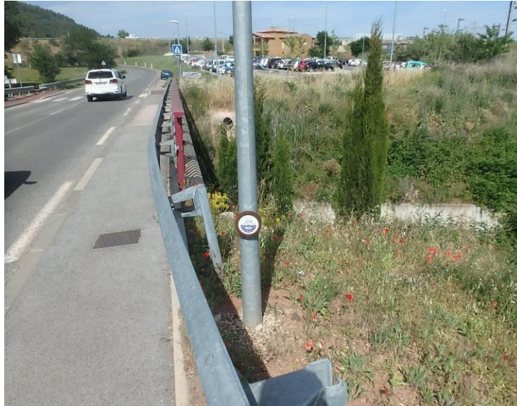
Repère de crue du 15 Juin 2010 sur l'Avenue des Laurons
