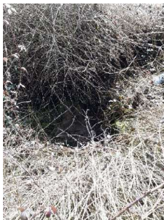
Exutoire de la STEP dans la faille
