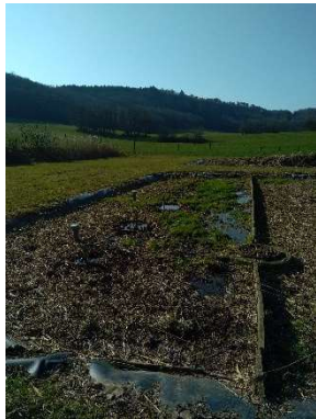
2 è étage de filtration après faucardage le 22.03.2022
