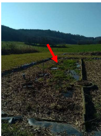
Figure 26 : Mauvaises herbes présentes sur le filtre de l'étage 2
