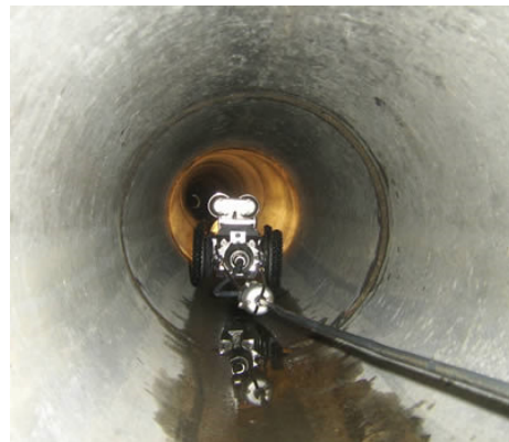
Principe de déroulement d'une inspection télévisée
