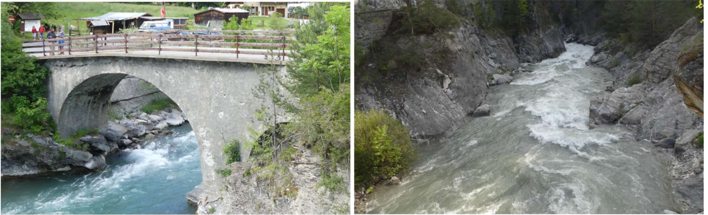
Fig. 27. Le pont de Pasquet vu de l'aval (à gauche) et entrée des gorges du Guil depuis le pont (à droite)
