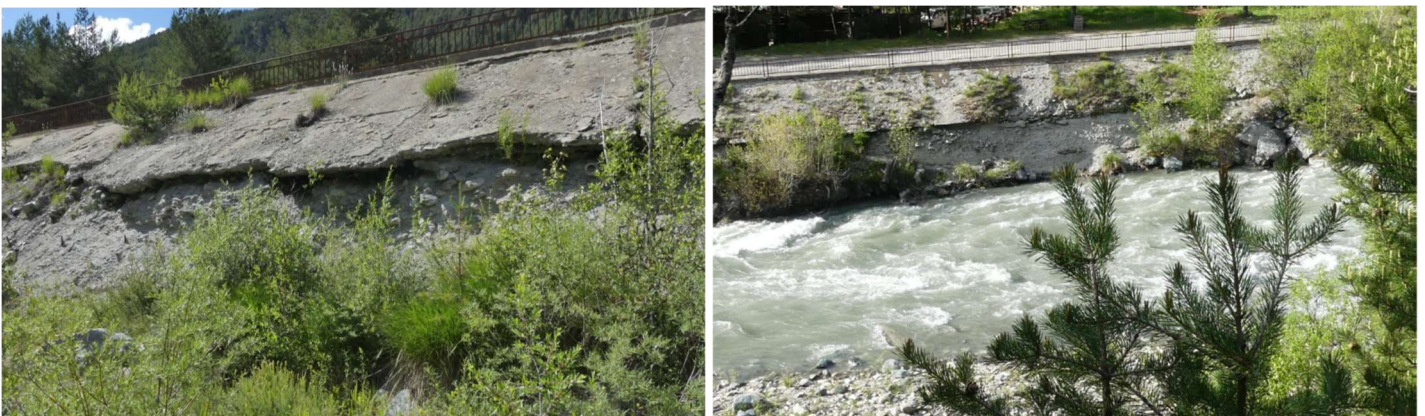
Fig. 32. A gauche : ouvrage de protection de la voie communale, en aval du seuil (limite amont du tronçon D) ; à droite : Ouvrage de protection de la voie communale, en aval du seuil (limite amont du tronçon A)
