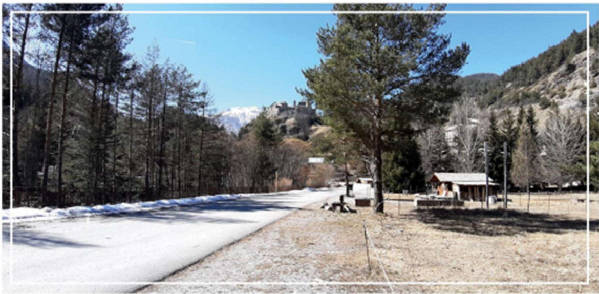
Fig. 86. Vue actuelle vers l'aval, depuis la RD 947 (au droit du profil P16_CD05)
