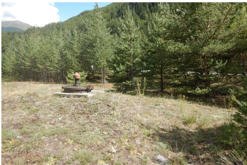
Fig. 62. Captage de Château-Queyras
