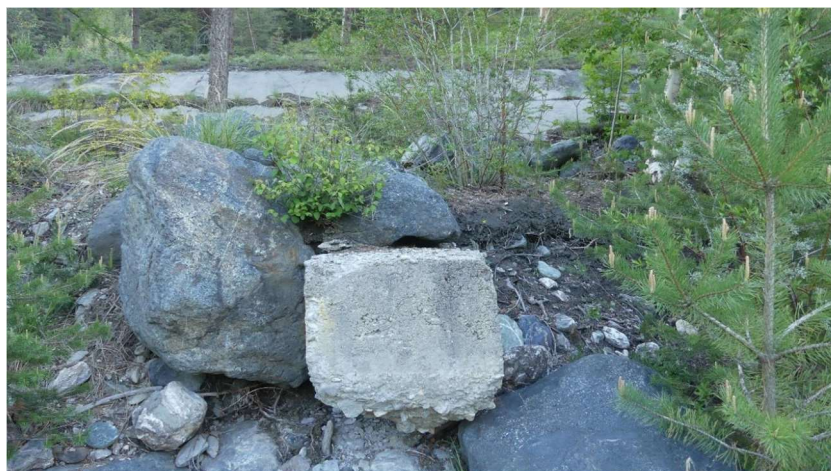
Fig. 10. Digue des Planissaux vue du lit (de haut en bas : perré béton, enrochements et épi court béton perché)
