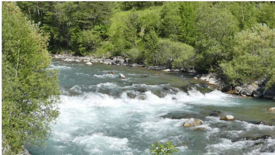
Fig. 30. Seuil sur le Guil réalisé en 1987 pour contenir l'incision
