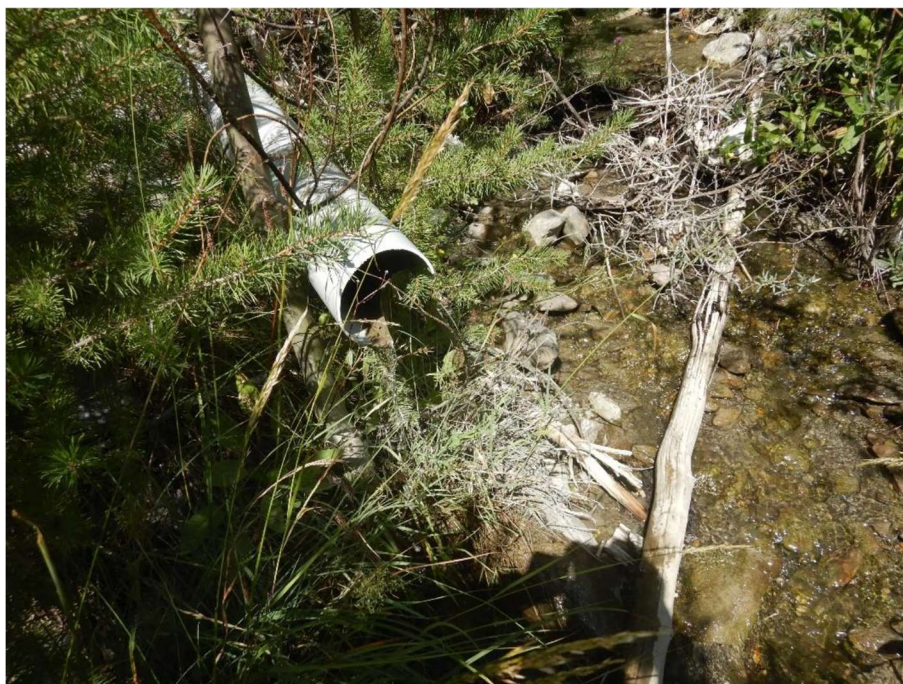
Fig. 67. Rejet non identifié dans le Guil au droit du torrent de Platenq
