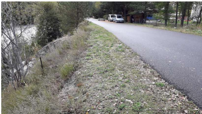
Fig. 55. Voie communale (vue vers l'aval vers le PK 21.700)
