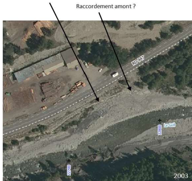
Fig. 22. Zone des Planissaux - photo aérienne de 2003 en aval de la zone
