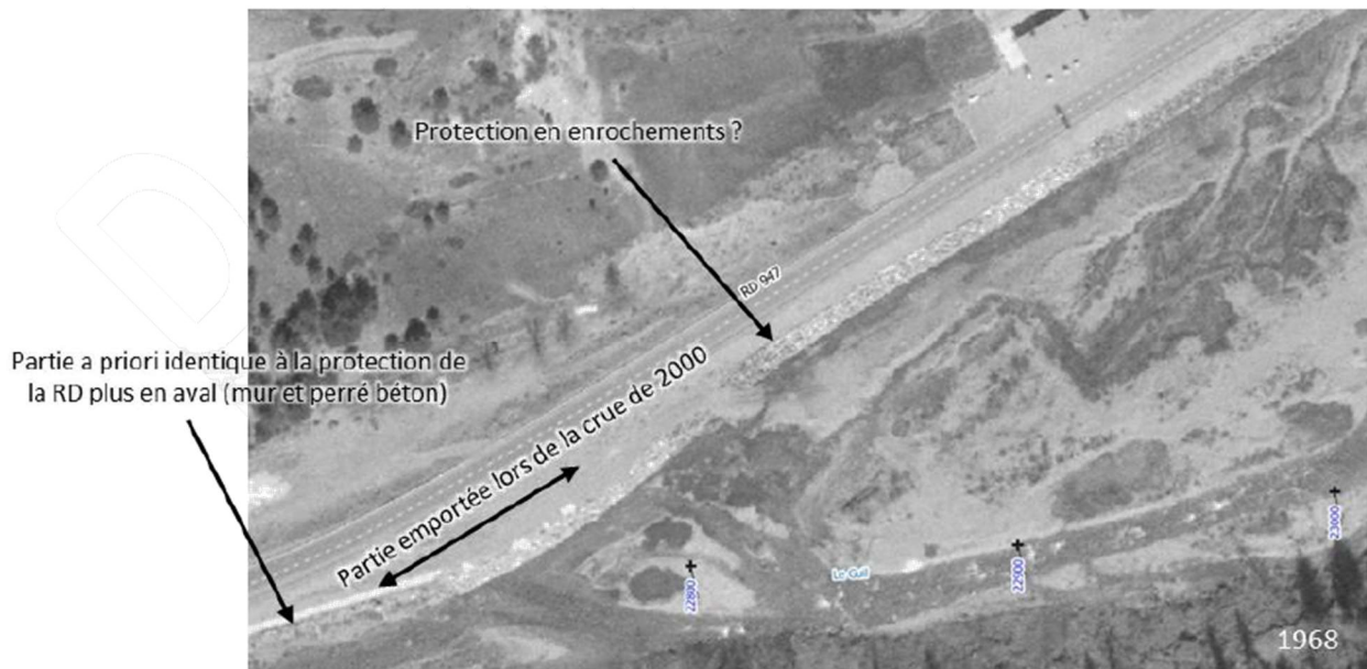
Fig. 20. Zone des Planissaux - vue aérienne de 1968 montrant la protection de la RD 947
