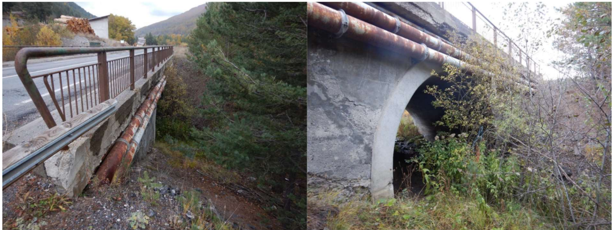
Fig. 58. Torrent de Platenq : vu de la rive droite en aval du pont de la RD 947 (gauche), vu de la rive droite en aval et en contrebas du pont de la RD 947 (droite)
