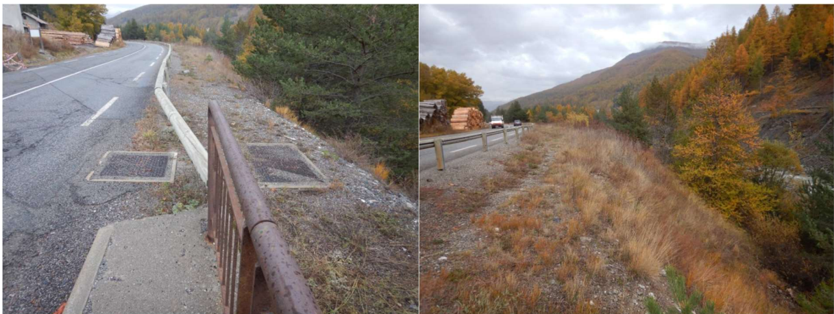
Fig. 59. Bas-côté étroit en amont du franchissement du torrent de Platenq par la RD 947 (vue vers l'amont) (gauche) et Bas-côté plus large au droit et en amont de la scierie (vue vers l'amont) (droite)
