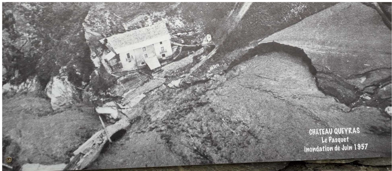
Fig. 28. La crue de 1957 au pont de Pasquet, débordement et engravement exceptionnel (extrait du panneau positionné sur le mur en rive droite du pont)
