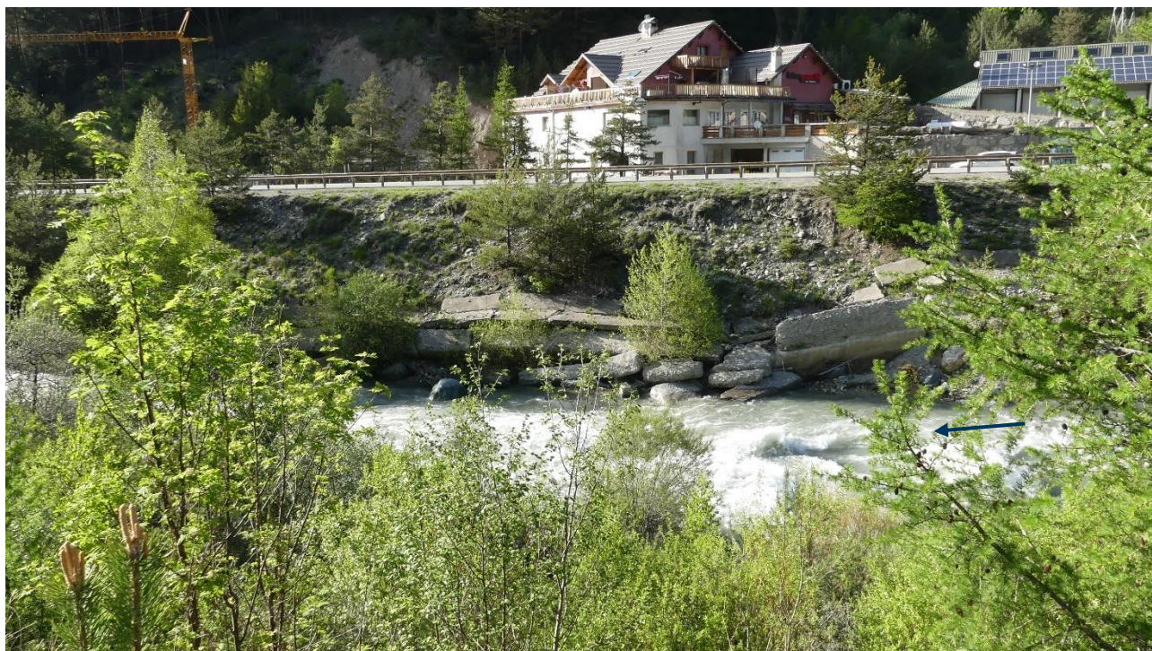
Figure 33 : Zone de la RD 947 - vue des dégradations au niveau de la supérette (partie amont du tronçon)
