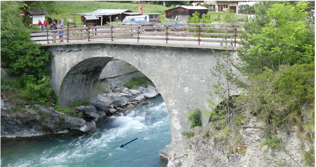
Figure 34 : Le pont de Pasquet vu de l'aval
