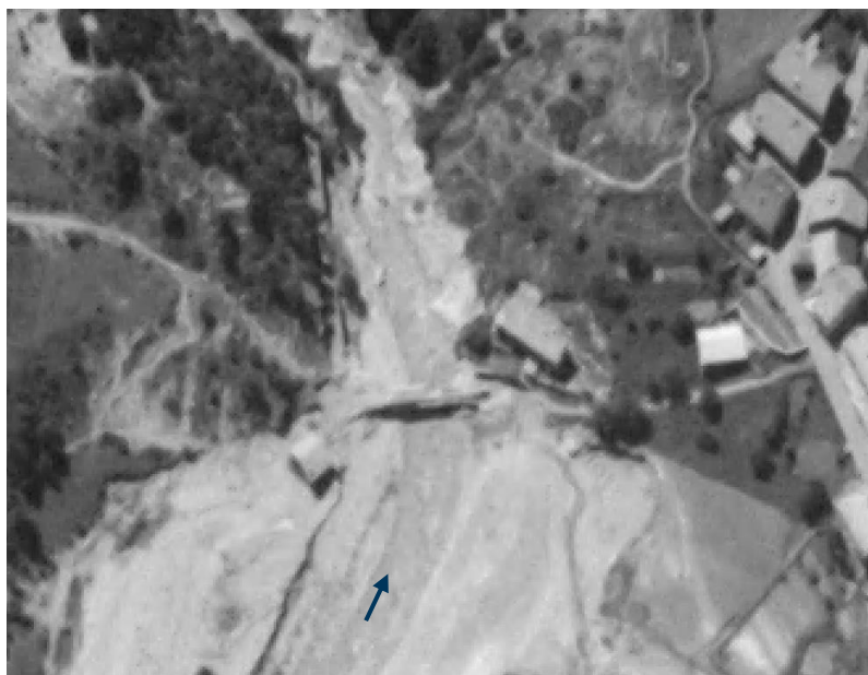
Figure 55 : Photo aérienne de juillet 1957 - zoom sur le pont de Pasquet
