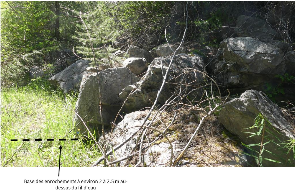
Figure 28 : Zone des Planissaux - protection existante de la RD 947 en aval de la zone
