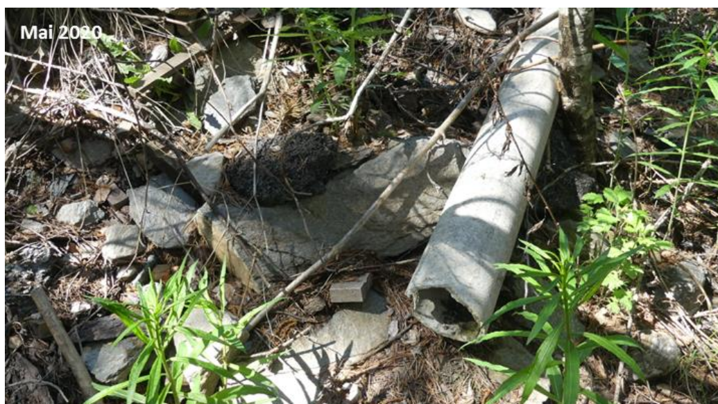
Figure 24 : Photo du pied de la décharge
