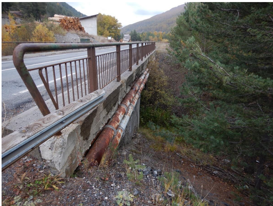
Figure 102 : Torrent de Plantenq vu de la rive droite en aval immédiat du pont de la RD 947
