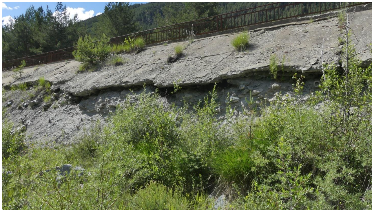
Figure 40 : Ouvrage de protection de la voie communale, en aval du seuil (limite amont du tronçon D)
