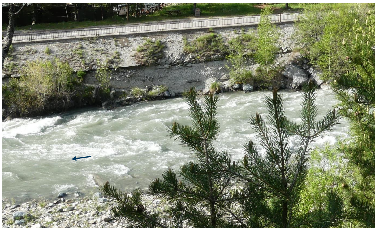
Figure 41 : Ouvrage de protection de la voie communale, en aval du seuil (limite amont du tronçon A)
