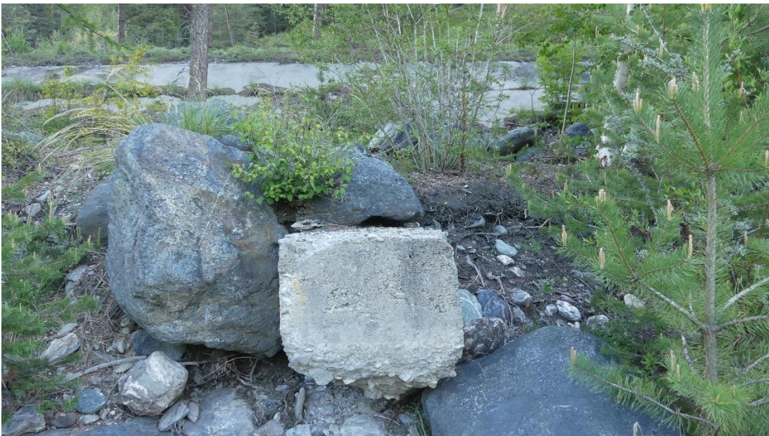
Figure 12 : Digue des Planissaux vue du lit (de haut en bas : perré béton, enrochements et épi court béton perché)
