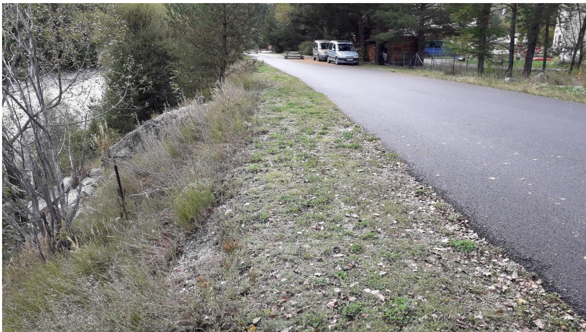
Figure 99 : Voie communale (vue vers l'aval vers le PK 21.700)
