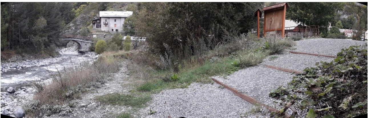
Figure 120 : Rampe d'accès au Guil pour les activités d'eaux-vives en amont du pont de Pasquet
