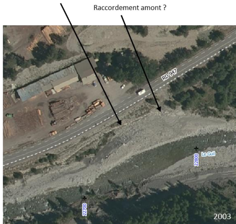
Figure 29 : Zone des Planissaux - photo aérienne de 2003 en aval de la zone
