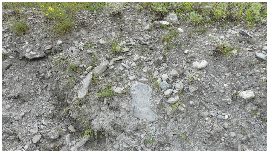
Figure 95 : Vue des matériaux constituant le remblai actuel de la RD 947 (talus côté versant, au droit de la supérette)
