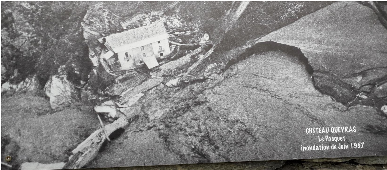
Figure 36 : La crue de 1957 au pont de Pasquet, débordement et engrèvement exceptionnel (extrait du panneau positionné sur le mur en rive droite du pont)
