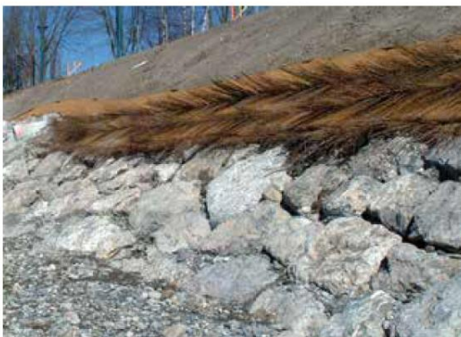
Figure 106 : Exemple de techniques végétales type couches de branches (Arve, source : Géni'Alp)
