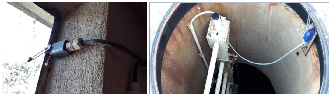
Figure 95 Exemple de détecteurs anti-intrusion installés au niveau des portes et des cuves
