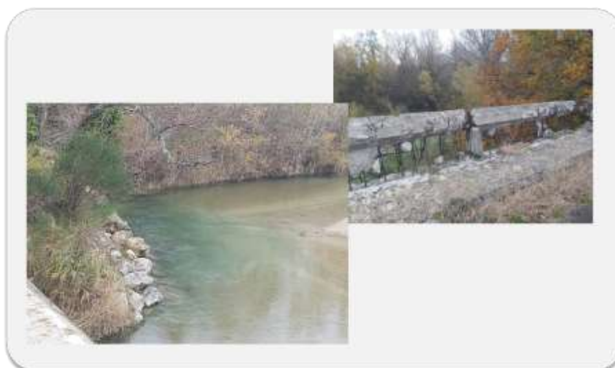
Figure 50 Vieux pont Violès
