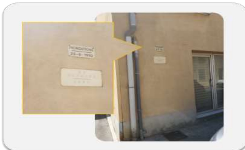
Figure 12 Repères de crues sur les façades de Bedarrides.
