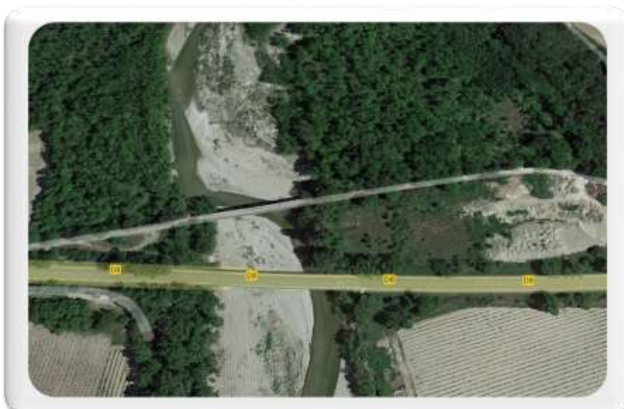
Figure 48 site potentiel sur l'Ouvèze à Violès
