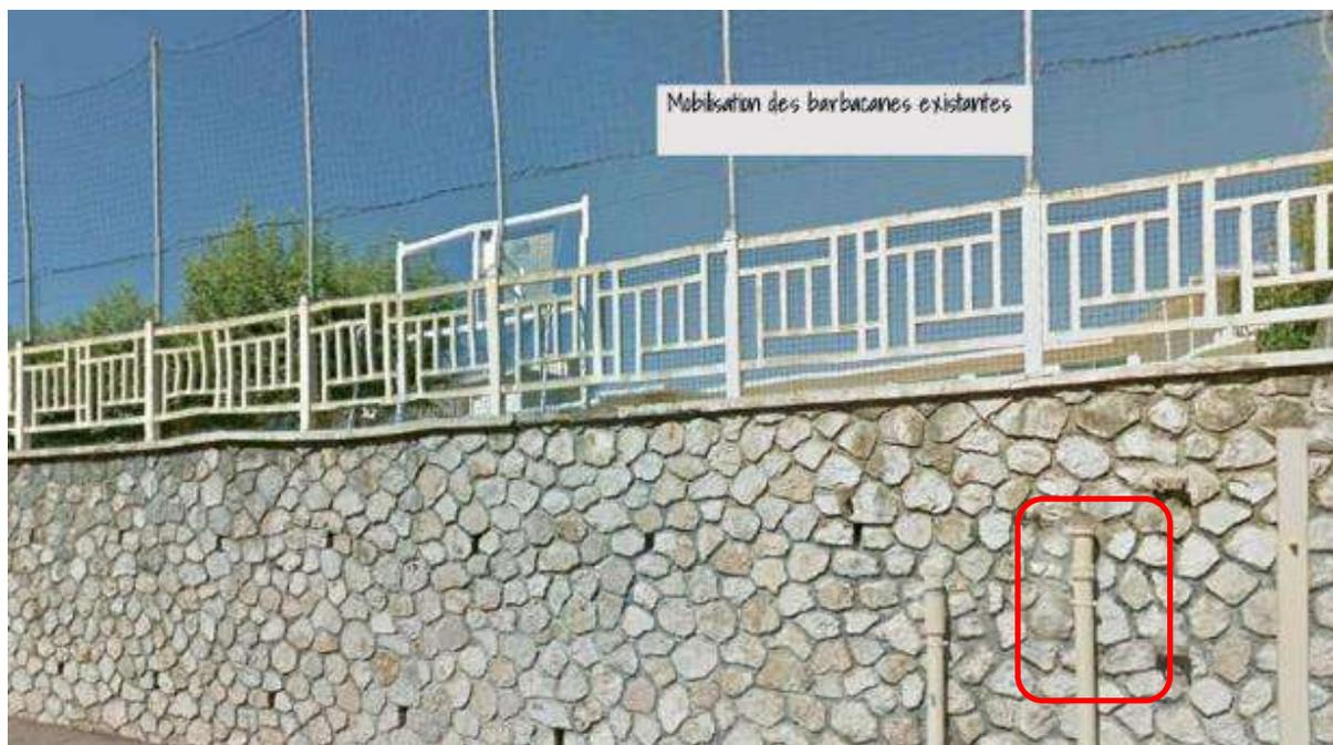
Cet exutoire fonctionne sous minimum 2m de charge ce qui offre une capacité d'évacuation théorique de 25l/s (loi d'orifice en DN100).
