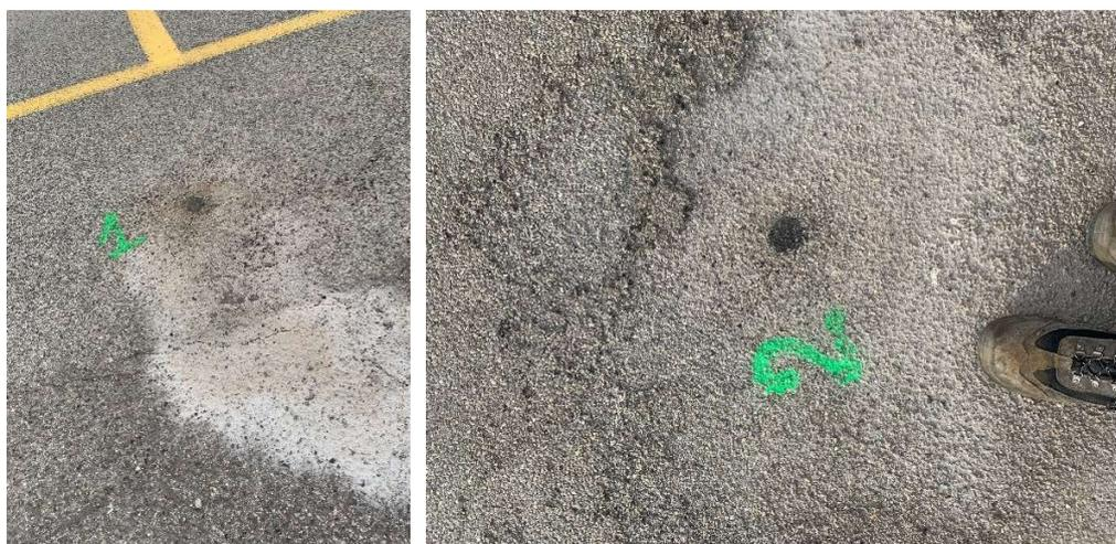
Sondages réalisés pour analyse de l'enrobé
