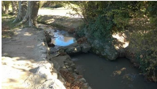
Figure 11 : Des ouvrages limitent la continuité écologique dans le parc
