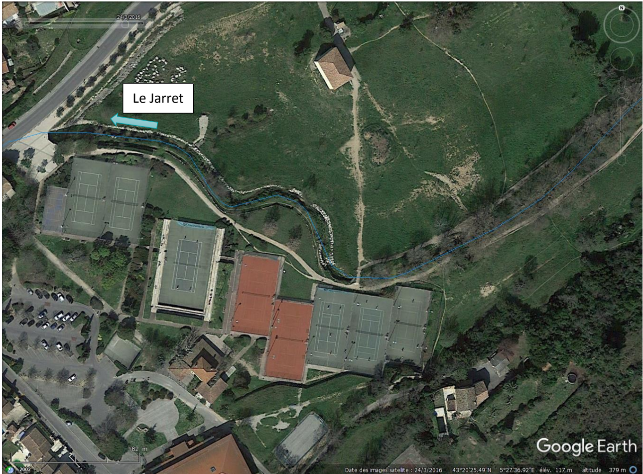
Figure 13 : Vue de 2016, le chemin a été emporté par une érosion de berge
