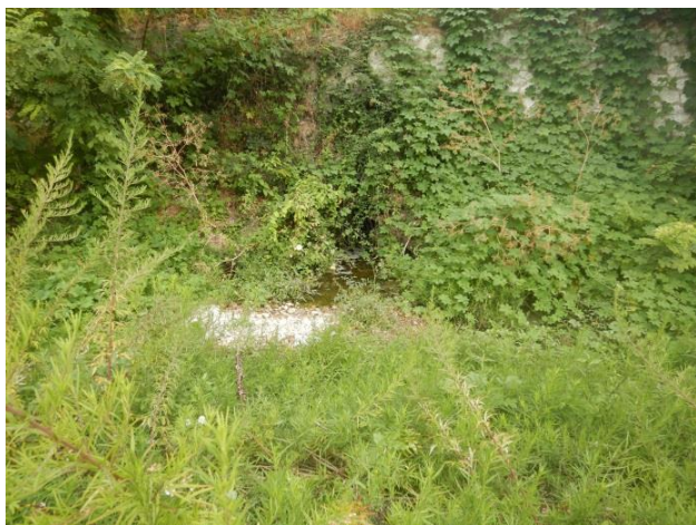
Désordre n° 13 : Rejet d'eau masqué par la végétation
