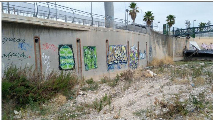
Photo 1 : Ouvrage de rejets en rive droite à l'aval de la Pugette
