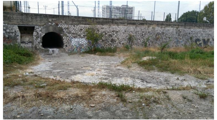
Photo 14 : Ouvrage de rejet en rive gauche en aval du pont Michelet
