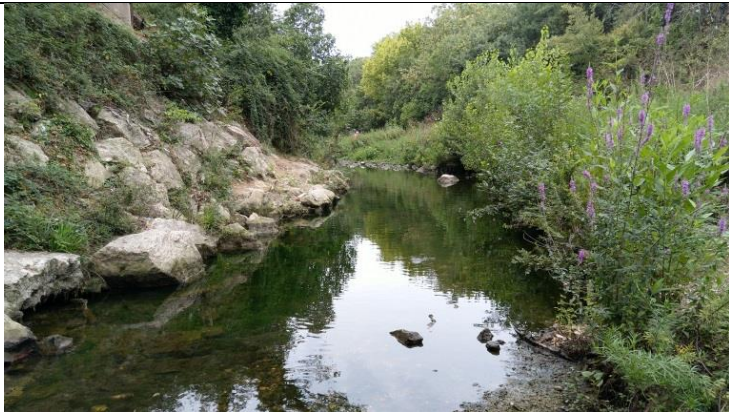
Photo 51 : Vue vers l'aval de l'enrochement à conforter
