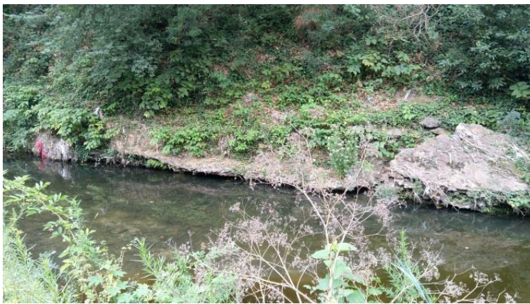
Photo 45 : Affouillement de la berge en rive gauche à l'aval de l'îlot de Mazargues à préserver
