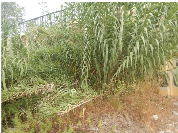
Désordre n° 33 : Végétation importante
