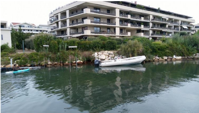
Photo 73 : Berge en enrochements libres au niveau de la Base nautique (rive droite). Stable depuis 2015
