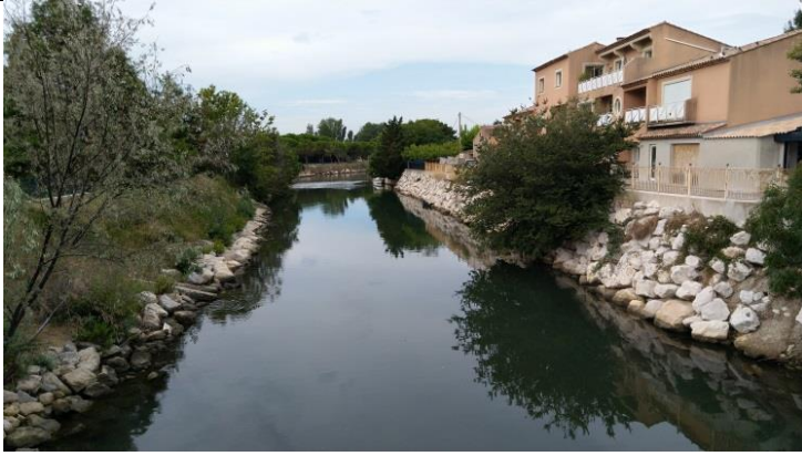
Photo 69 : Berges à l'aval du pont Borély. Stable depuis 2015
