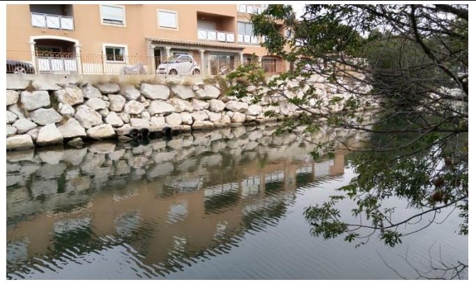
Photo 70 : Berge en enrochement (rive droite). Stable depuis 2015
