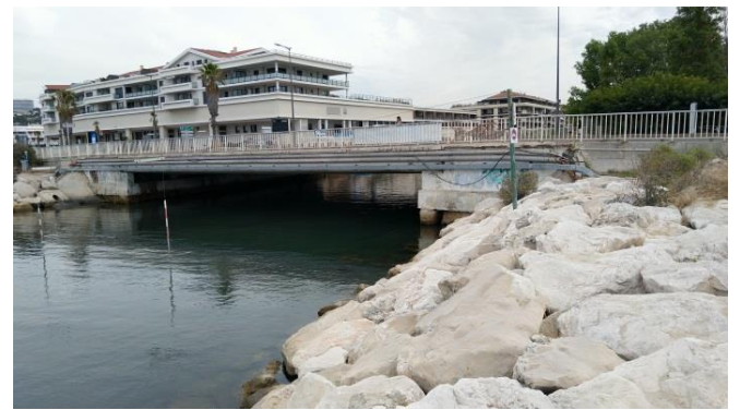
Photo 74: Pont de l'Avenue Pierre Mendès France (en aval). Stable depuis 2015
