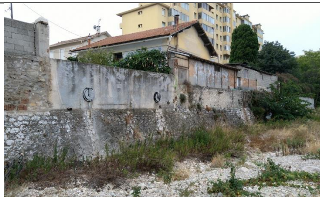
Photo 2 : Ouvrages de rejets en rive gauche à l'aval de la Pugette
