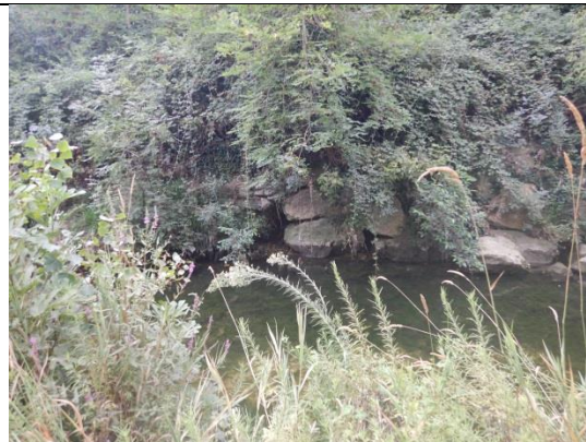
Photo 56 : Berge en enrochements libres en rive gauche avec présence importante de végétation (au niveau de l'école de Danse)
