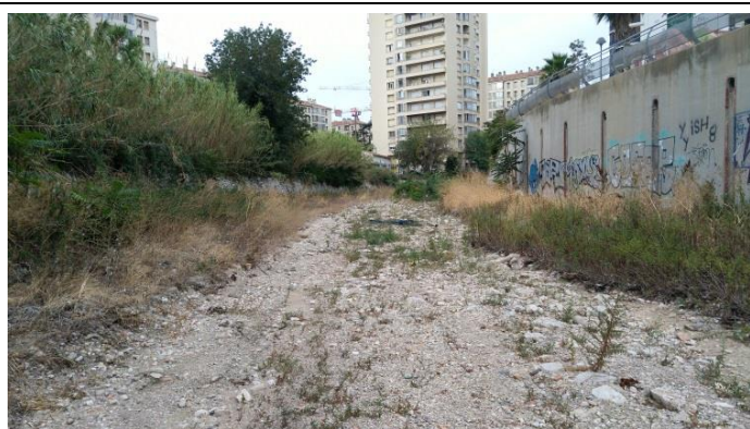
Photo 3 : Vue en direction de l'amont
