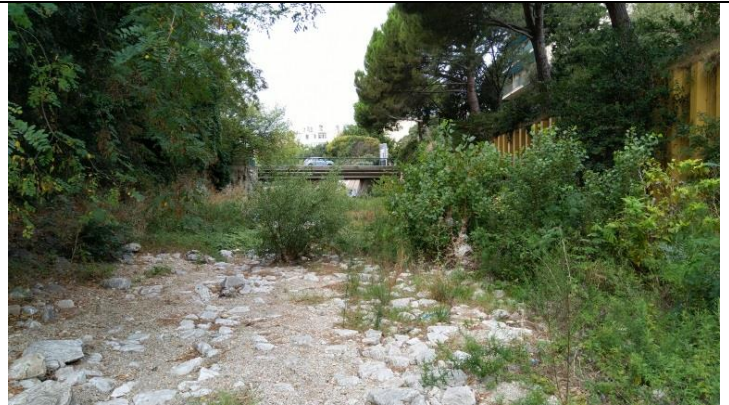
Photo 30 : Fond du lit en galets liaisonnés en amont du pont
