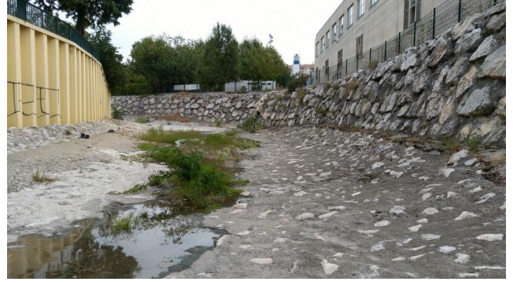
Photo 26 : Fond du lit artificiel au niveau de l'ASPTT
