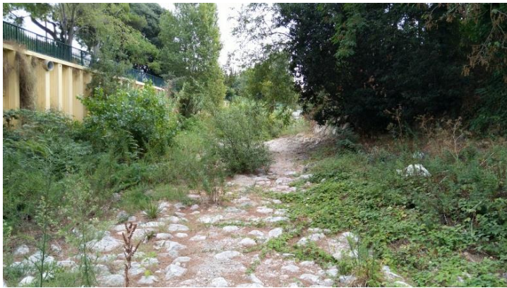
Photo 31 : Vue vers l'amont depuis le pont de Mazargues
