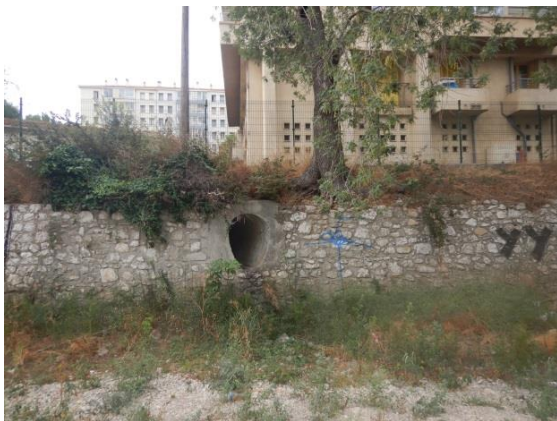
Photo 7 : Ouvrage de rejet en rive gauche
