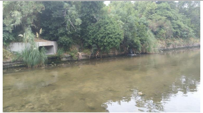
Photo 64 : Rejets en rive gauche depuis le sentier pédestre de l'Huveaune
