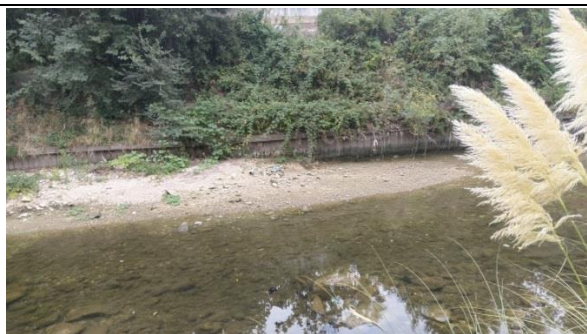
Photo 61 : Atterrissement en rive gauche au niveau du parc Henri Fabre à préserver pour diversifier les habitats
