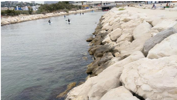
Photo 75 : Enrochements libres à l'aval du pont Pierre Mendès France (rive droite). Stable depuis 2015
