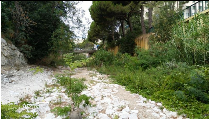
Photo 29 : Vue vers l'aval (en amont du pont de Mazargues)
