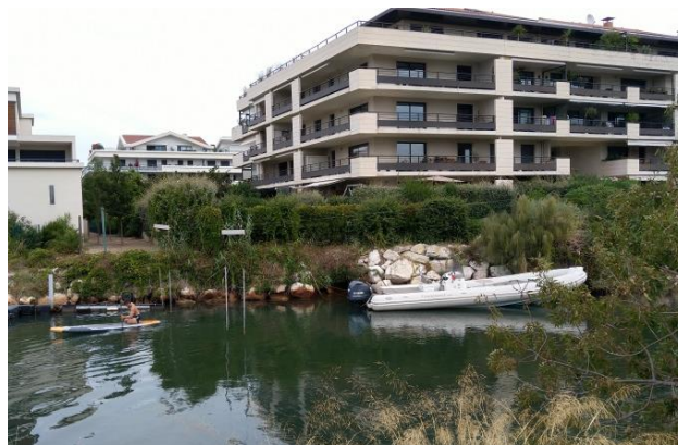
Désordre n° 62 : Végétation importante sur berge et instabilité
