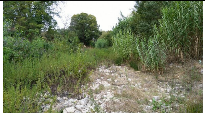
Photo 34 : Vue vers l'amont au niveau de l'îlot de Mazargues
