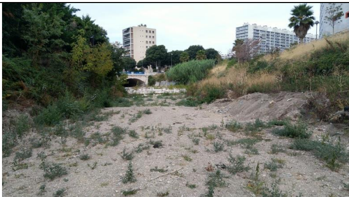
Photo 9 : Dépôts sédimentaires et végétation importante des berges à l'amont du pont Michelet
