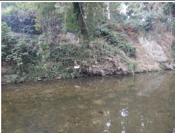
Photo 47 : Erosion de la berge en rive gauche sans enjeux
