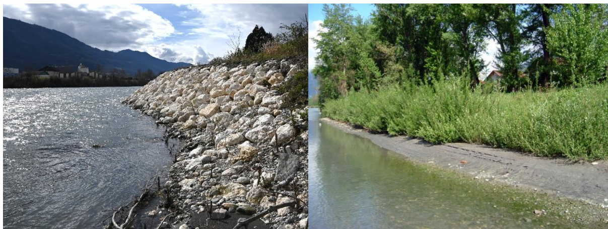
Photo 1. Ouvrages de protection de berges issus de différentes techniques.
