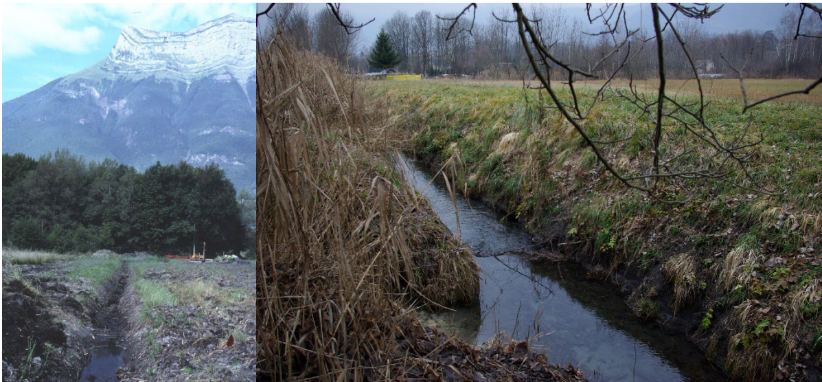
Figure 14 - Creusement d'un fossé (1980) et encaissement actuel
