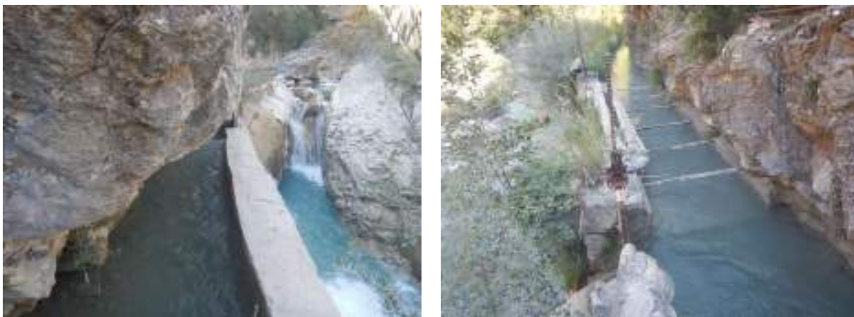
Figure 29 : Granulométrie grossière observée au fond du canal entre les 2 vannes de décharge amont (gauche) et absence de graviers à l'aval de la deuxième vanne de décharge (droite).
