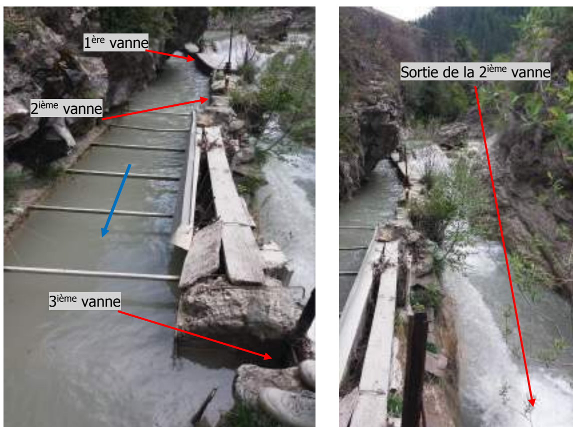
Figure 7 : Vue du canal et des vannes de décharges.
