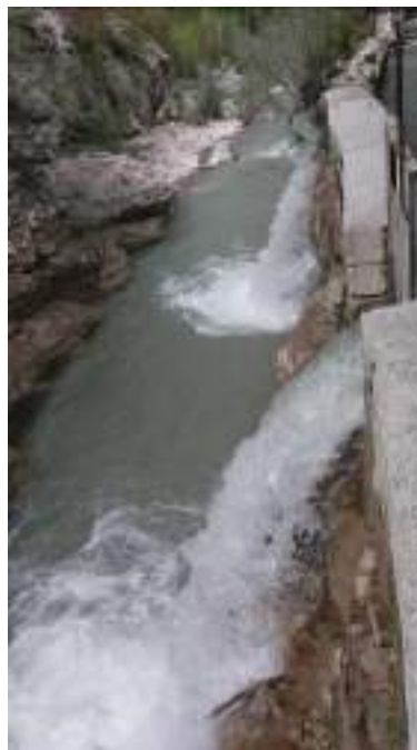
Figure 35 : Jets d'eau issue des vannes de décharge.
