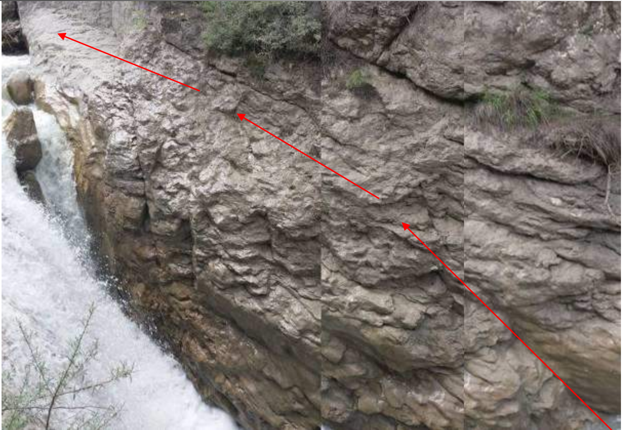
Figure 32 : Vue du cheminement potentiel pour anguille en rive droite.
