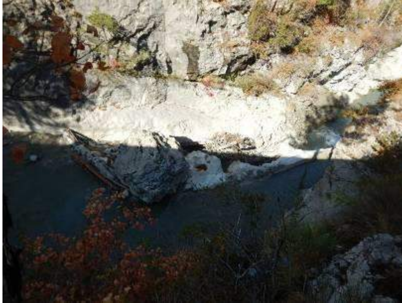
Figure 28 : Vue du seuil de prise depuis la rive droite.
