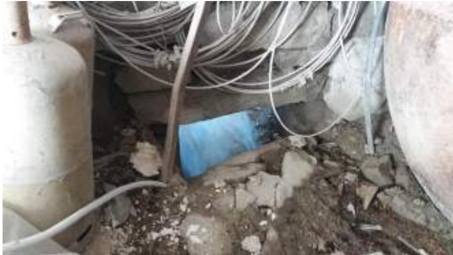
Figure 4 : Conduite enterrée en aval de la vanne.
