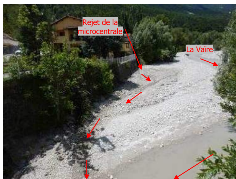
Figure 6 : Rejet de la microcentrale Marcel dans la Vaire, vue depuis le pont de la RN 202 vers l'amont (Photo du 29/06/2017)
