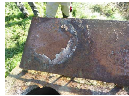
Trappe d'accès au lit bactérien
