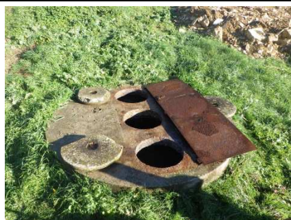
Décanteur digesteur
