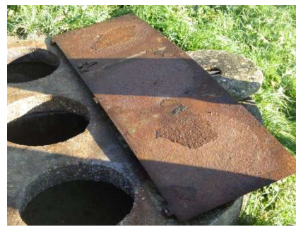
Trappe d'accès au décanteur
