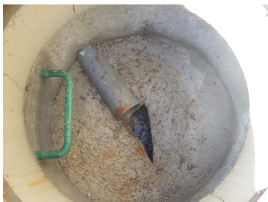
Photo de l'intérieur du regard(1)
