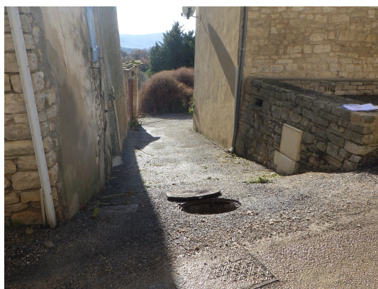
Photo de l'environnement du regard(2)
