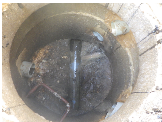
Photo de l'intérieur du regard(1)
