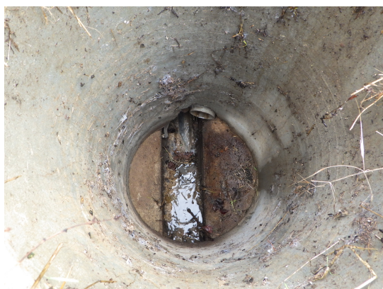
Photo de l'intérieur du regard(1)
