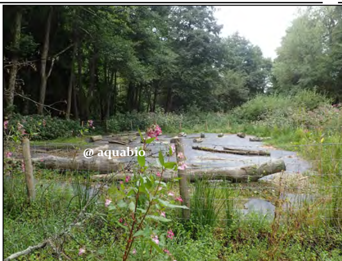
bâchage des terres concassées dans une zone humide
