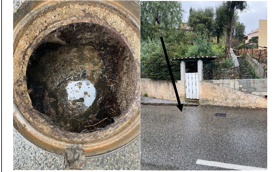
Regard amont R3223 Débit important d'un branchement, raccordement EP suspecté en domaine privé
