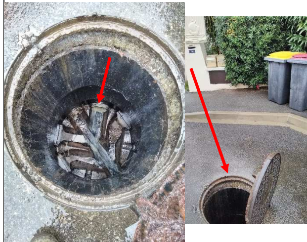
Regard amont R3223 Débit important d'un branchement, raccordement EP suspecté en domaine privé
