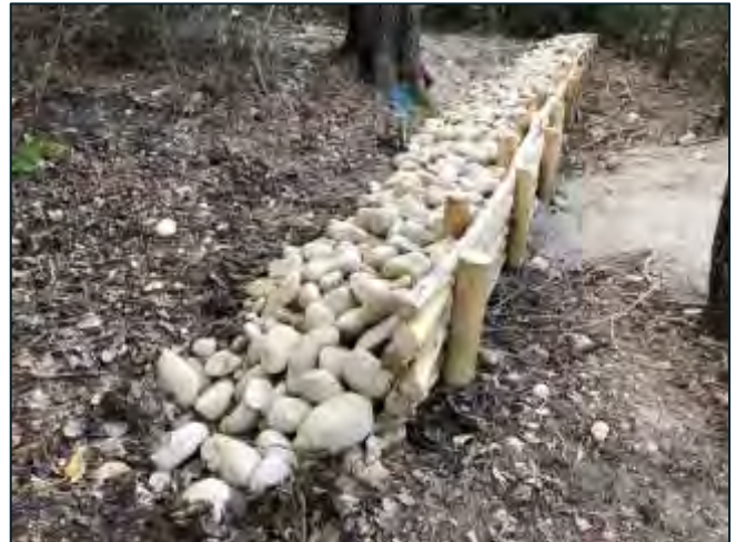
Pose des lames de bois et galets
