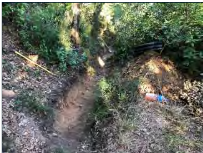
Creusement de la tranchée
