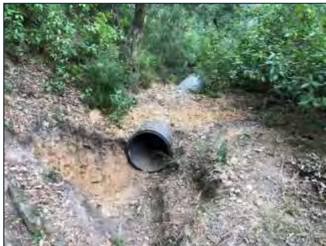
Placement d'une canalisation
