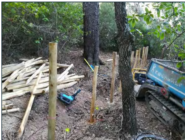
Pose des piquets de maintien dans la tranchée
