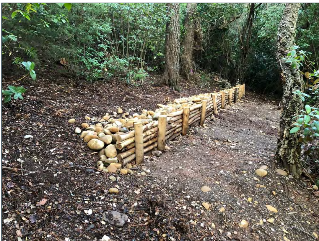
Aspect de la fascine minérale finalisée
