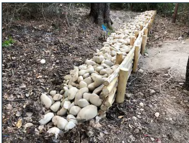
Pose des lames de bois et galets
