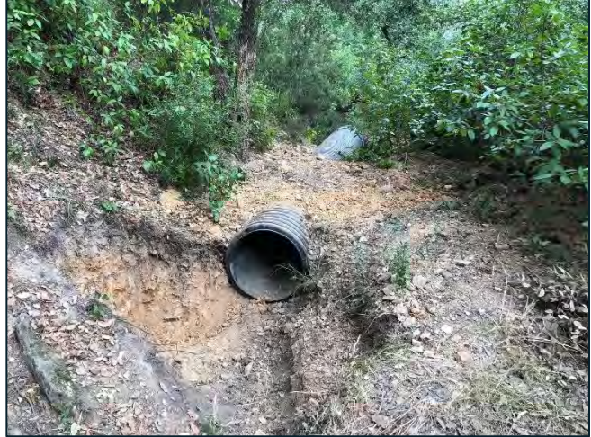
Placement d'une canalisation
