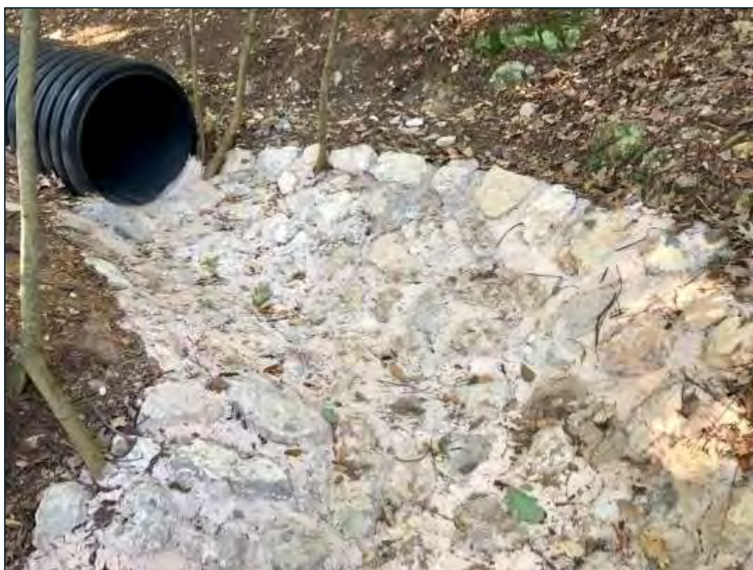
Pose des matériaux dispersifs en sortie de canalisation
