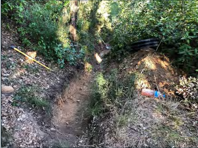
Creusement de la tranchée
