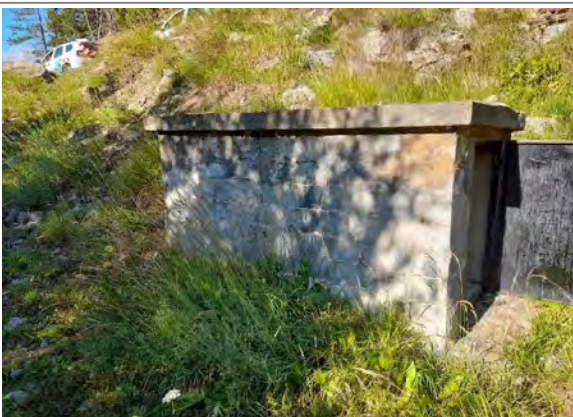
Ouvrage de captage
