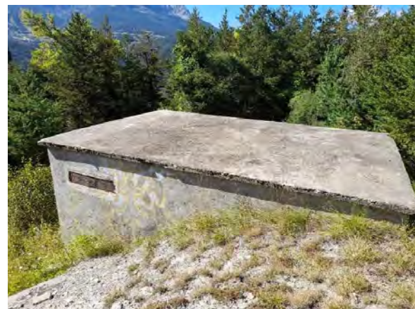
Couverture du bâtiment technique
