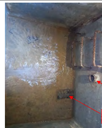
Surverse en béton au pied de l'échelle d'accès
