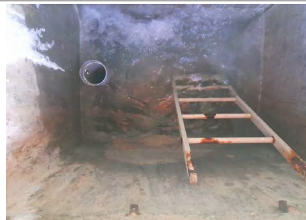
Echelle d'accès à l'intérieur de l'ouvrage, trop plein en PVC
