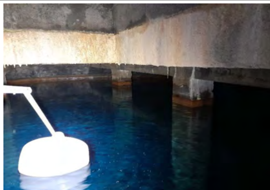
Structure de la cuve en poteaux-poutres
