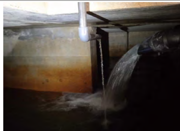
Adduction d'eau et d'eau chlorée dans le réservoir
