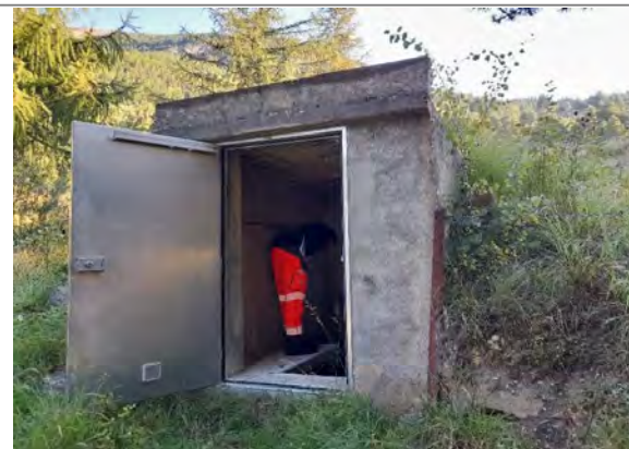
Porte d'accès à l'ouvrage de captage
