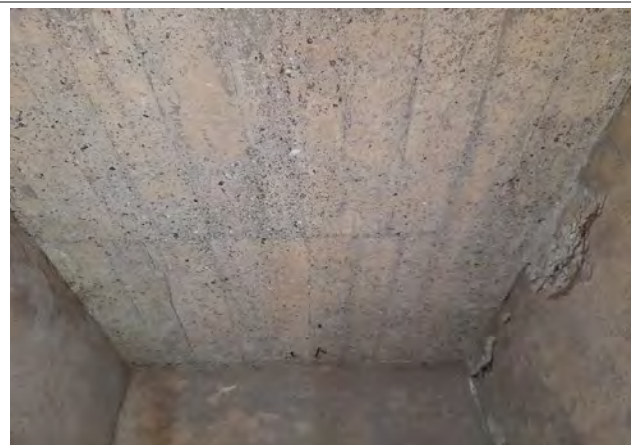
Couverture du bâtiment technique
