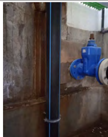
Trop plein de la cuve
