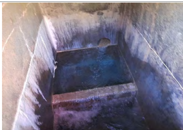
Vue du drain depuis l'intérieur de l'ouvrage
