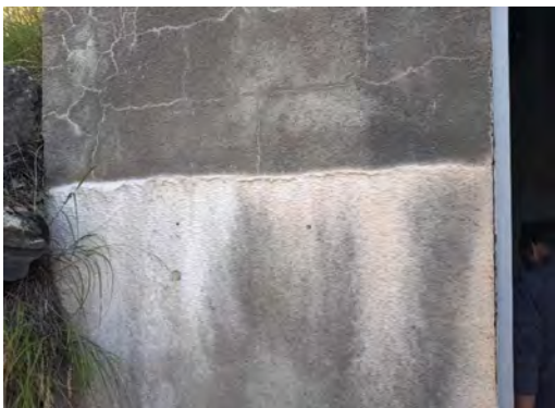
Faiçonnage des voiles
