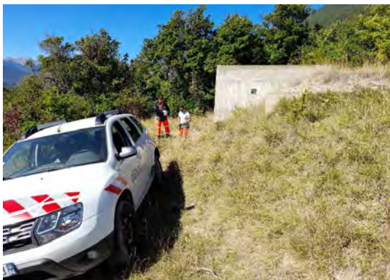
Accès au réservoir de Guillem Maurin
