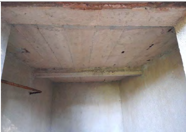
Couverture du bâtiment technique
