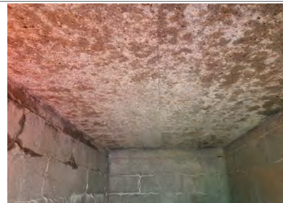
Couverture de l'ouvrage de captage, voiles en maçonnerie
