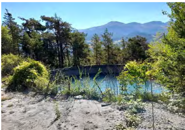
Réservoir d'arrosage à proximité du réservoir Le Chastellaret
