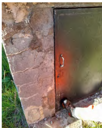
Porte d'accès à l'ouvrage de captage
