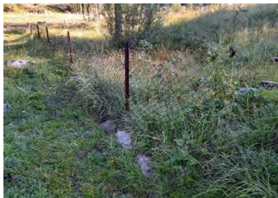
Grillage du périmètre de protection immédiate du captage
