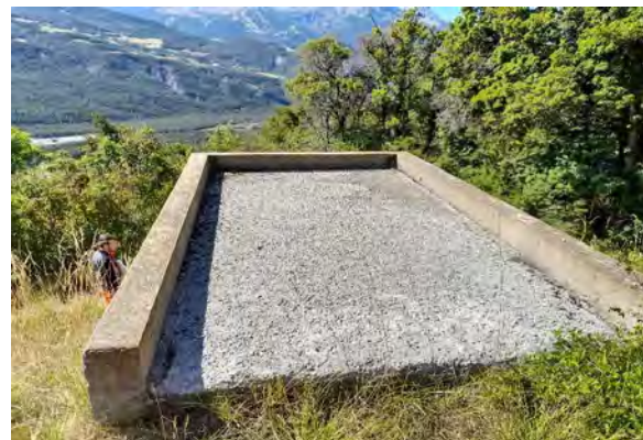
Couverture du bâtiment technique
