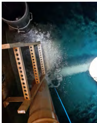
Echelle d'accès à l'intérieur de la cuve
