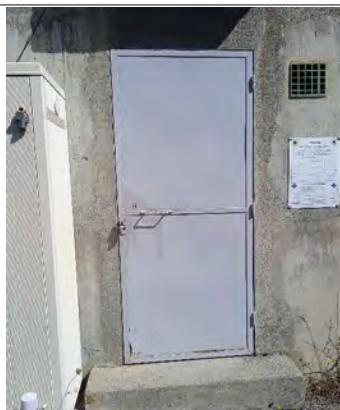
Porte métallique d'accès au réservoir, logette à chlore sur la gauche
