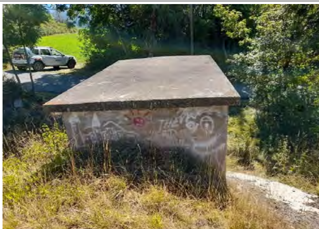
Couverture du bâtiment technique
