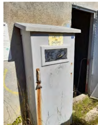
Logette à chlore accolé au bâtiment technique
