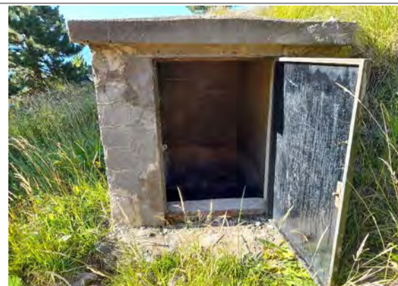
Ouvrage de captage
