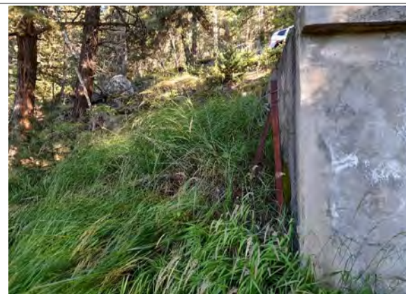
Grillage du périmètre de protection immédiate de la zone de captage
