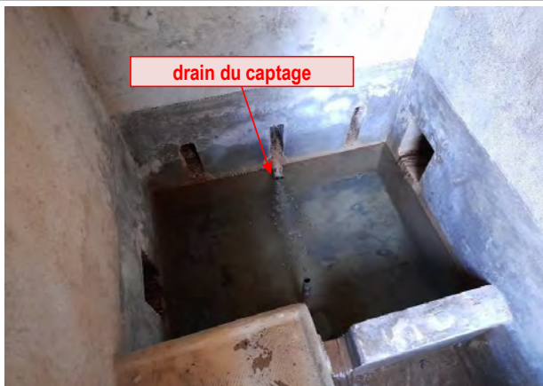
Intérieur de l'ouvrage de captage
