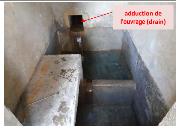
Intérieur de l'ouvrage de captage
