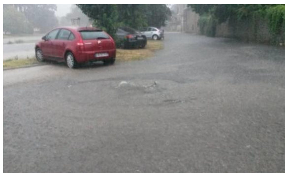
Photo 1 : regard qui déborde
