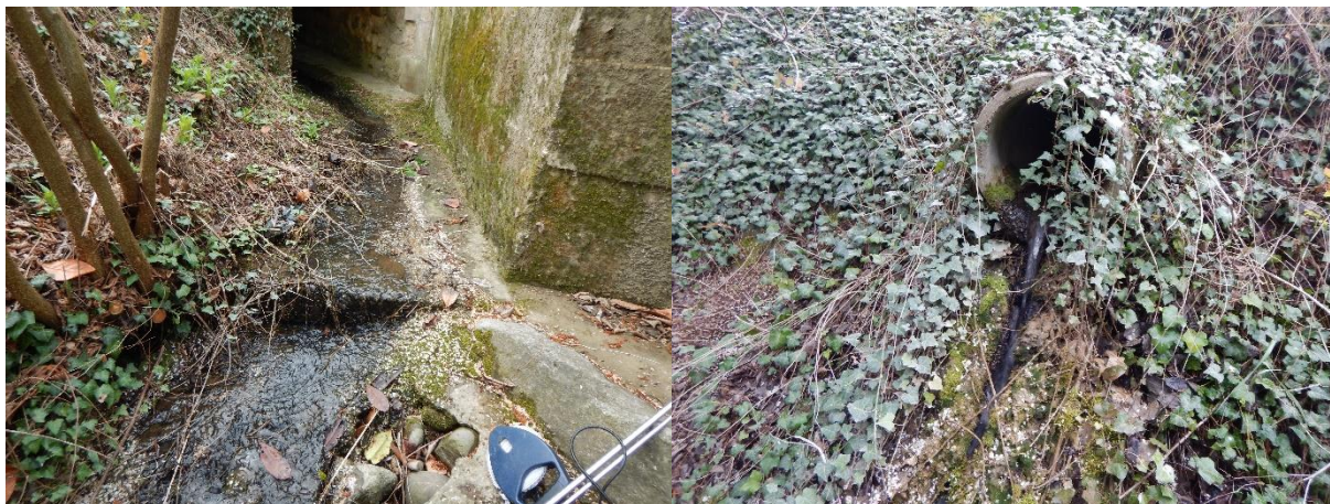
Figure 2-7 : Ruisseau amont (à gauche) et apport d'une buse au ruisseau (droite)
