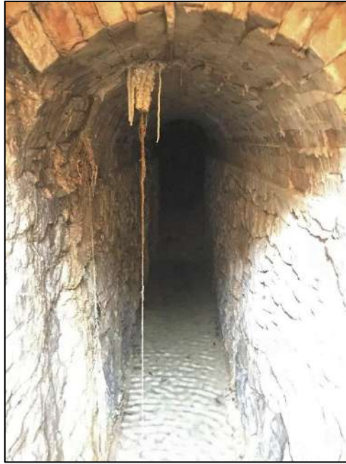
Figure 24 : Entrée de la galerie de captage de la source du Terrail implantée dans les formations pliocènes du coteau de Laye à Alex.
