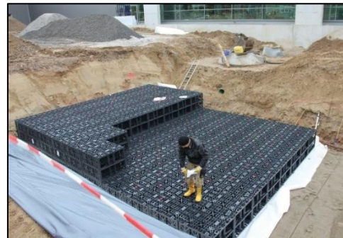
Photo 4 : Mise en place d'un bassin enterré à structure alvéolaire
