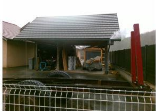
Gouttière de toiture
