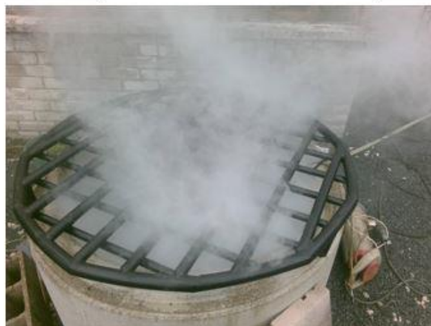
Trop plein d'un puits
