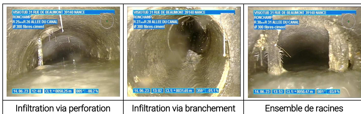
Figure 68 : Localisation des défauts Rue du Canal
