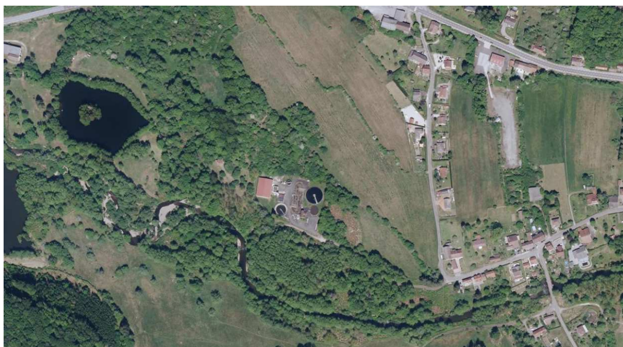
Figure 22 : Localisation et vue aérienne de la station d'épuration
