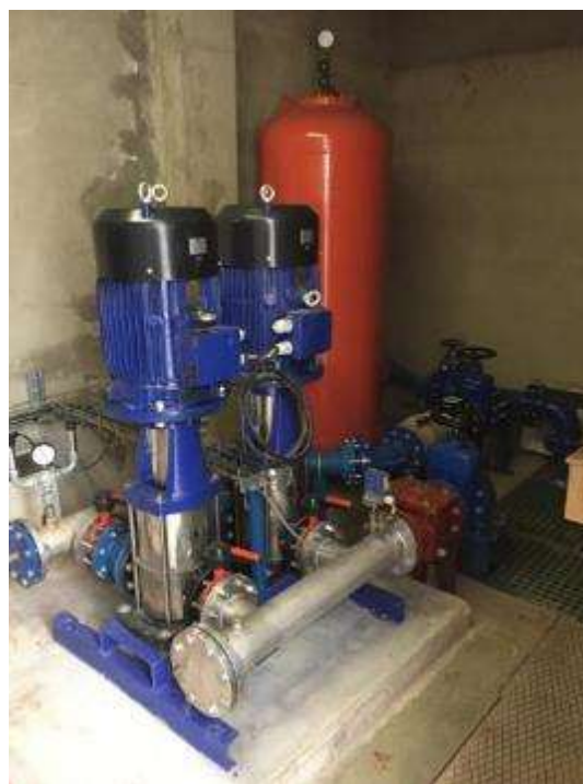
Intérieur de l'ouvrage
