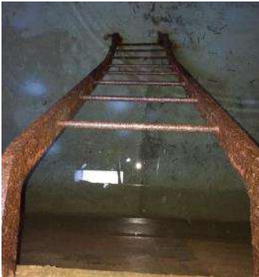
Accès au fond de la cuve
