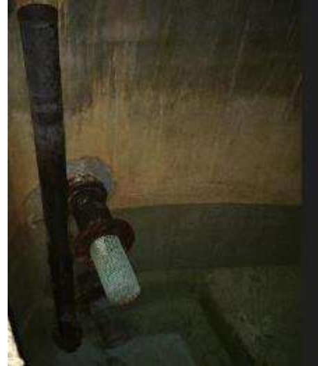
Intérieur de la cuve
