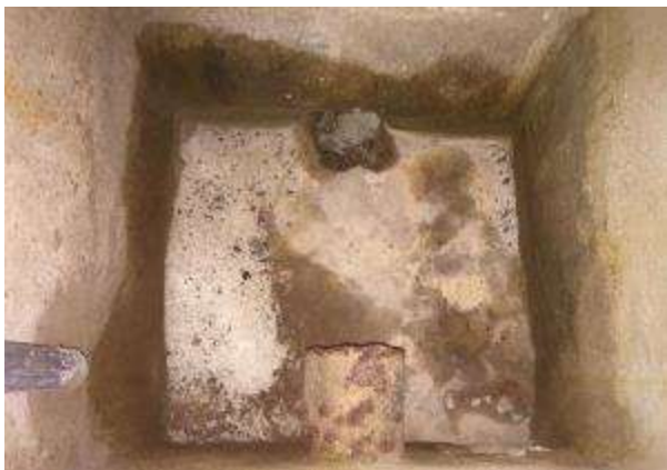
Regard du trop-plein et vidange
