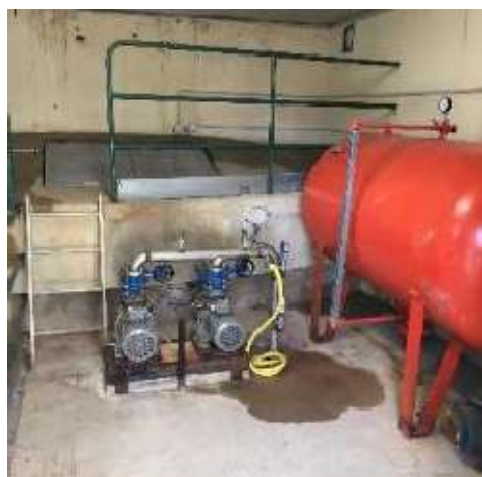
Intérieur de l'ouvrage
