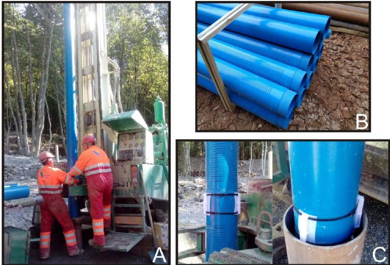
Figure 8 : (A) Mise en place des tubes PVC ; (B) Tubes PVC pleins et crépinés ; (C) Centreurs
