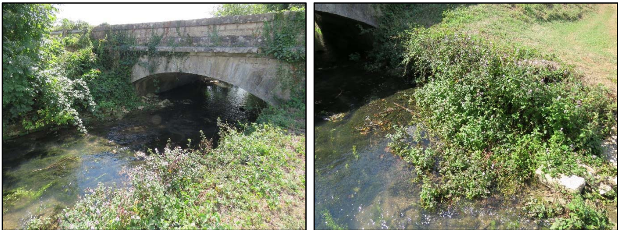
La partie Nord du tronçon étudié, au niveau du pont localisé à proximité de Maizières, est particulièrement favorable à l'Agrion de Mercure
