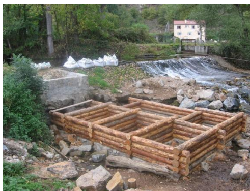
Fig. 28. Passe à poissons en bois sur l'Anzon (42)
