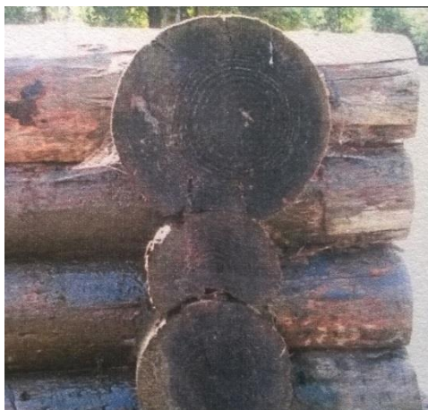
Fig. 27. Exemple de mise en œuvre des rondins
