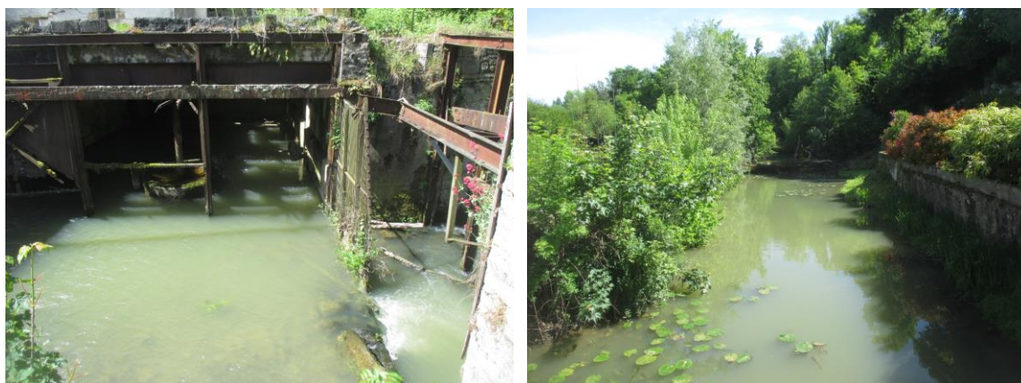
Fig. 7. Vannages de l'ancien moulin de Moncey et canal d'amenée en amont immédiat
