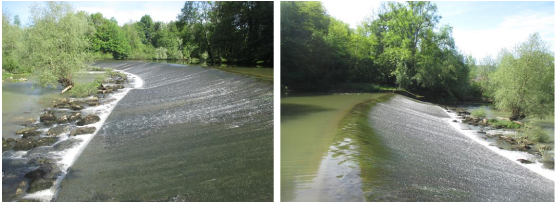
Fig. 3. Barrage de Moncey
