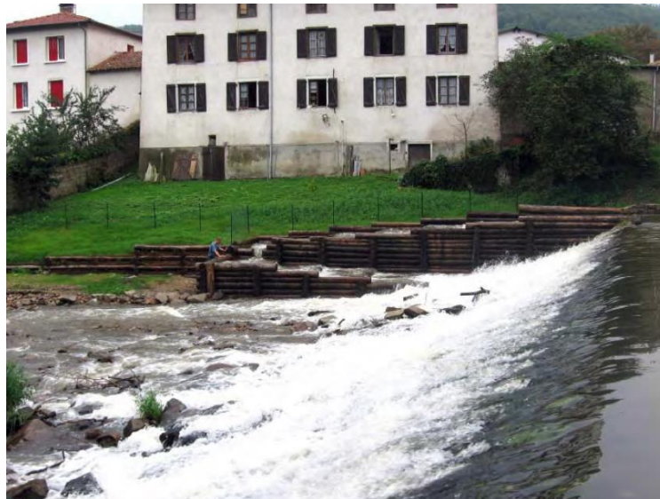
Fig. 26. Passe à poissons en bois sur le Lignon (42)
