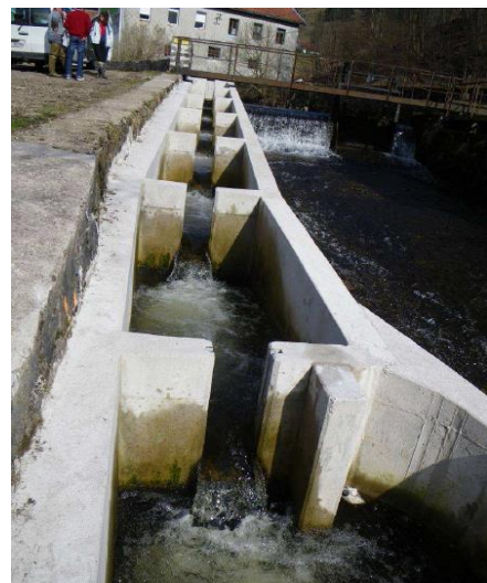
Fig. 33. Exemples de passes à bassins successifs
