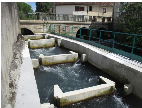
Fig. 33. Exemples de passes à bassins successifs
