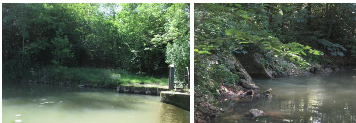
Fig. 8. Remblai de l'entrée du canal et ouvrage d'alimentation associé
