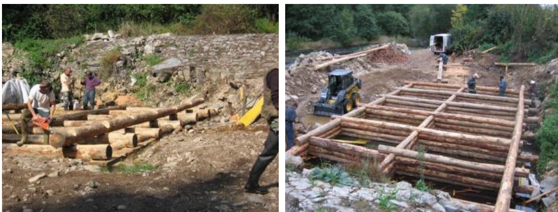
Fig. 38. Mise en œuvre de la fuste pour la réalisation d'une passe à poissons en bois
