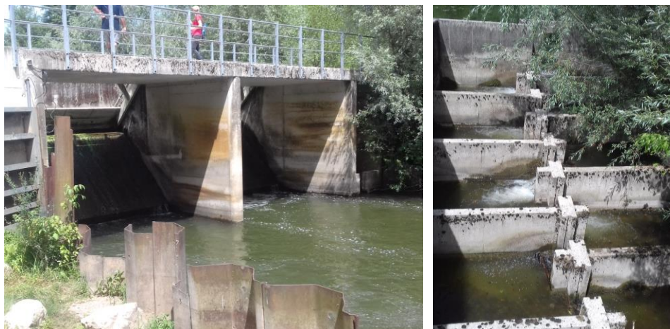
Fig. 11. Microcentrale d'Aulx-les-Cromary et passe à poissons associée
