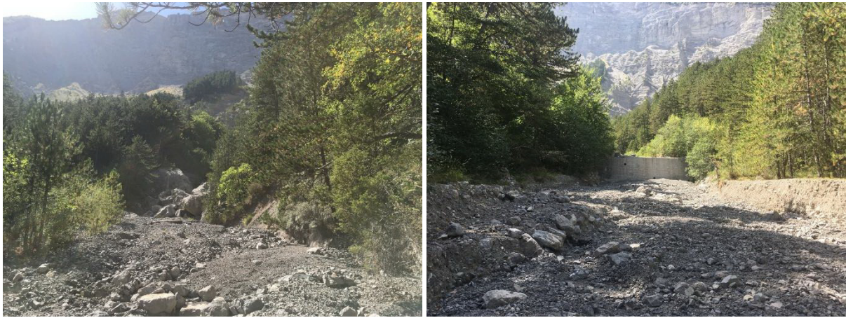
Figure 21 : Amont du barrage B14 avec nappes de charriage et très gros blocs stockés en pied de ravin (gauche) Lit large avec dépôts de charriage en amont du barrage B13 (droite)
