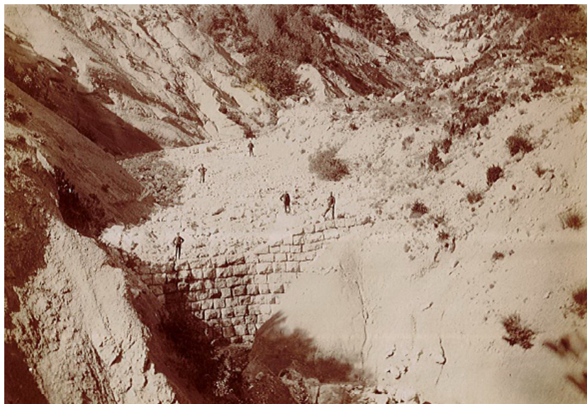
Figure 41 : Ouvrage vraisemblablement situé derrière le barrage actuel B11
