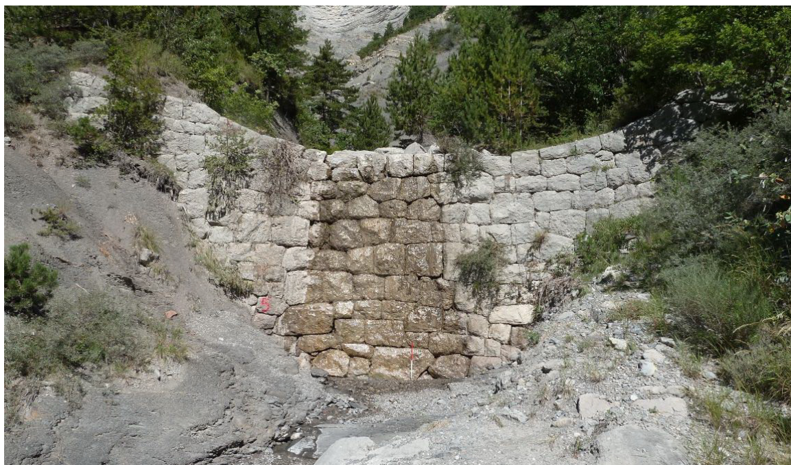
Figure 48 : le barrage B5
