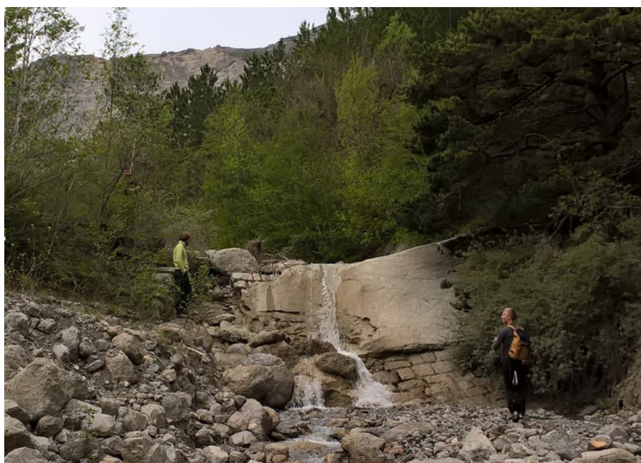
Figure 45 : Ouvrage B4 (origine Pont et Chaussées)
