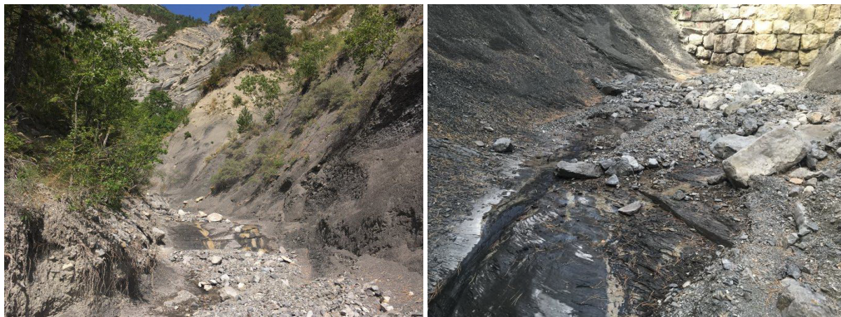
Figure 25 : Affleurement du substratum en amont du barrage B7 et au pied du barrage B6
