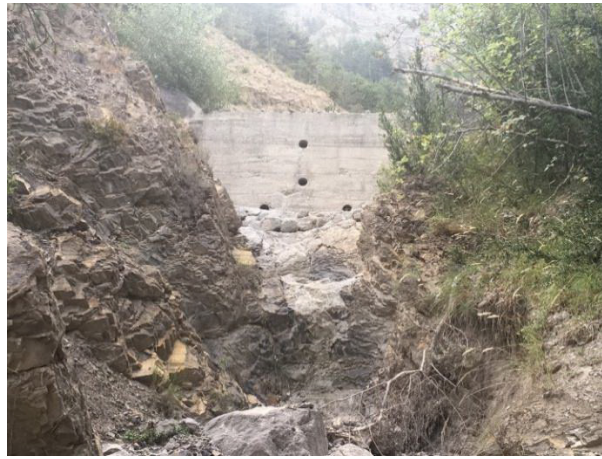
Figure 30 : Affleurement du substratum au niveau du barrage B1
