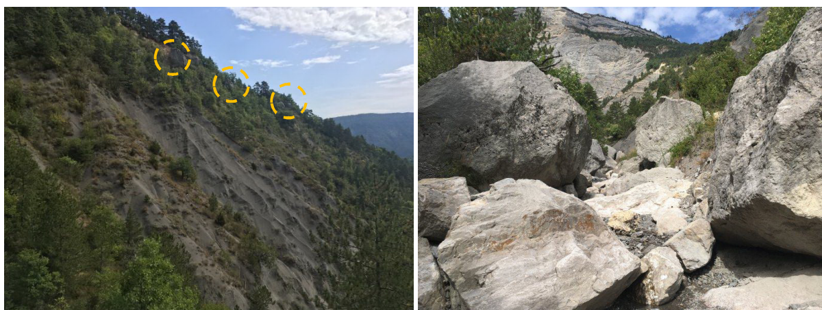
Figure 26 : Versant rive gauche entre barrages B6 et B4 avec très gros blocs surplombant le versant (gauche) Blocs sur substratum affleurant en fond de lit (droite)
