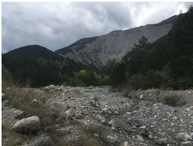
Figure 22 : Vue d'ensemble du ravin de Trescherennes et amont du barrage B6
