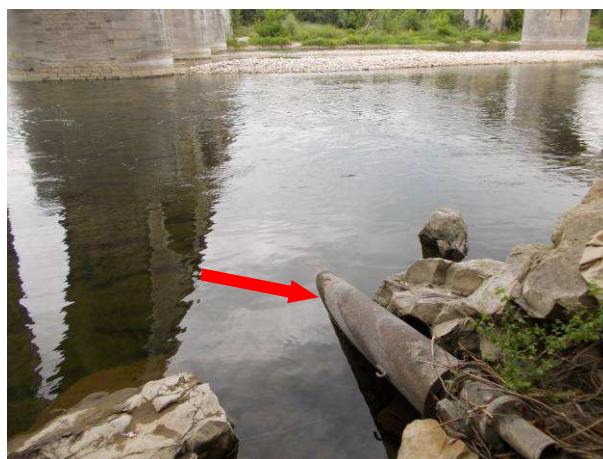
Emplacement de la sonde (RD)
