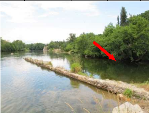
Vue générale de la station
