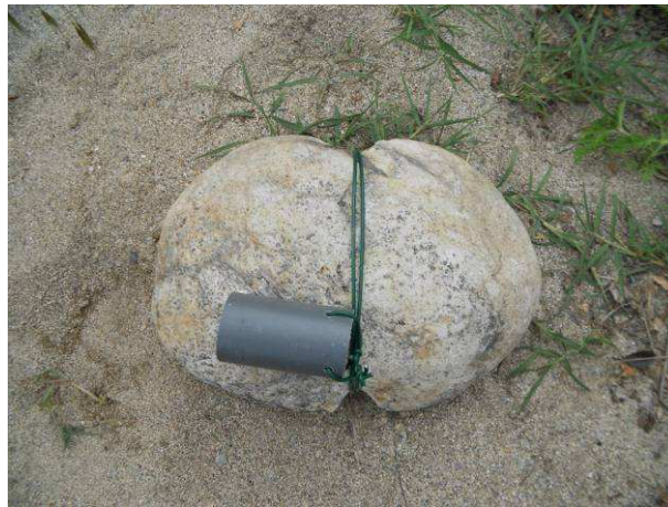
Figure 1: Fixation par fil de fer plastifié + pierre
