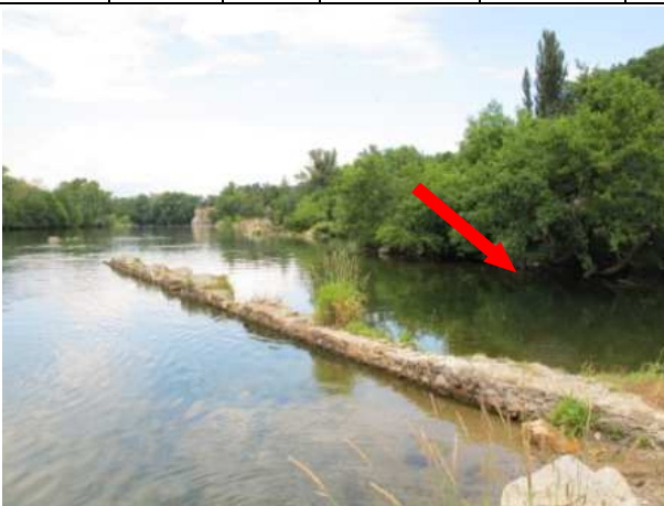
Vue générale de la station
