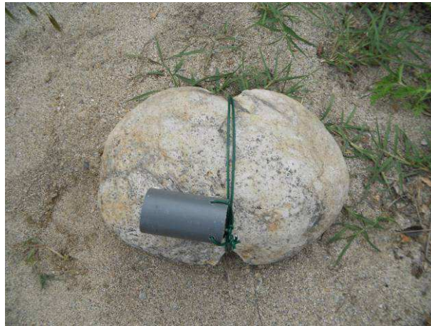
Figure 1: Fixation par fil de fer plastifié + pierre
