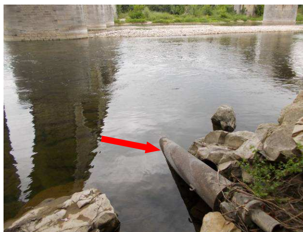
Emplacement de la sonde (RD)
