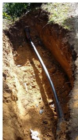
Figure 6 A gauche : canalisation gravitaire et à droite : canalisation de refoulement
