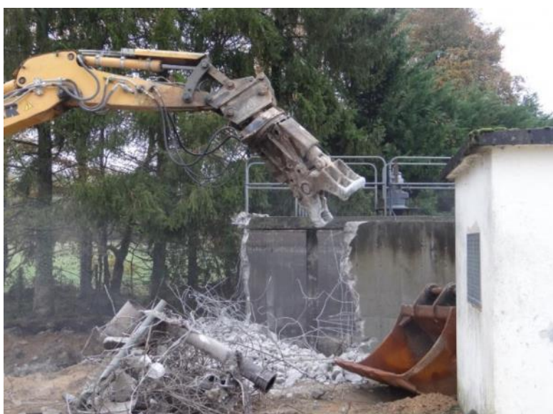
Figure 34 Démolition de l'ancienne STEU Source : commune de Pigny 33
