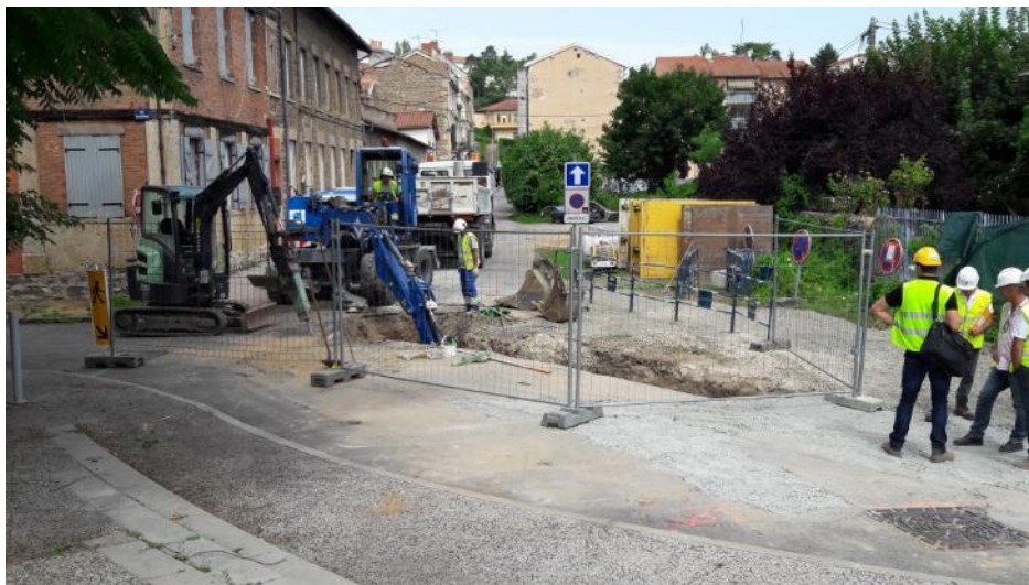
Figure 16 Travaux de mise en séparatif du réseau d'eau pluviales Source : Commune de l'Arbresle 16
