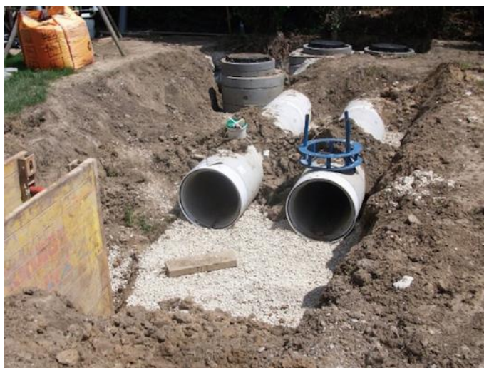
Figure 17 Travaux de mise en séparatif du réseau d'assainissement Source : Cecotech 17
