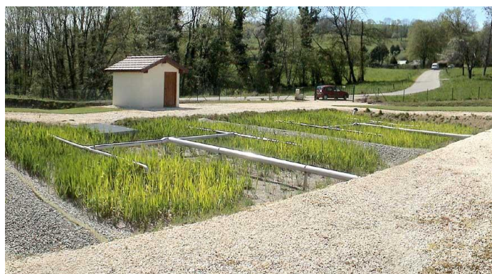
Figure 28 Filtre planté de roseaux Source : commune d'Epersy 27
