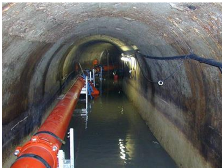
Figure 10 Travaux spéciaux : canalisation d'eaux usées posée dans une galerie souterraine existante d'amenée des eaux Source : Montmasson
