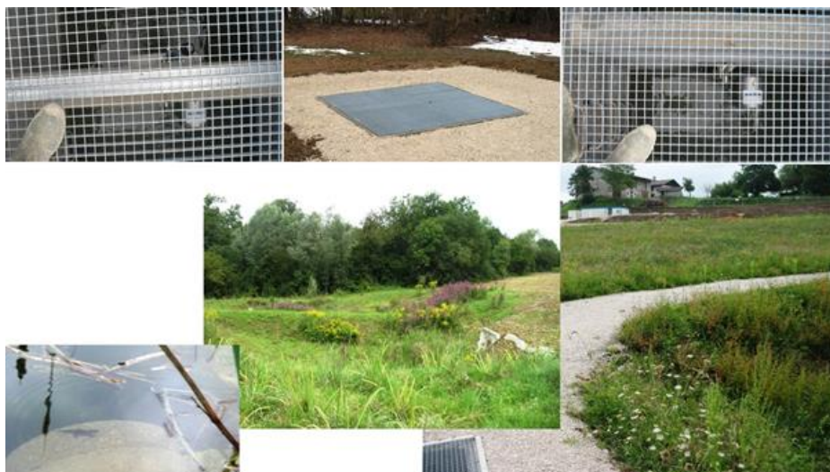
Figure 46 Réservoirs de régulation des eaux pluviales pour une réutilisation Source : Montmasson
