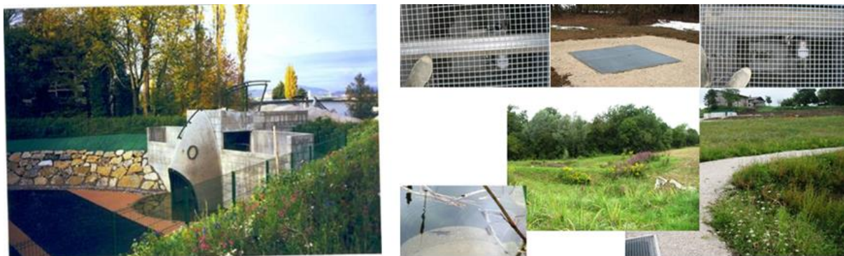
Figure 47 A gauche : ouvrage de stockage-restitution et à droite : réservoir de régulation des eaux pluviales pour une réutilisation Source : Montmasson
