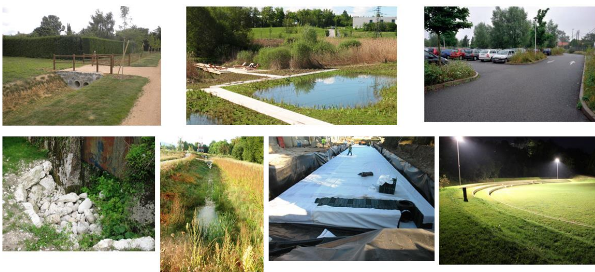
Figure 44 En haut, de gauche à droite : noue d'infiltration, bassin d'infiltration et chaussée réservoir. En bas, de gauche à droite : puits d'infiltration, tranchée d'infiltration, mise en place de SAUL et surface désimperméabilisée
