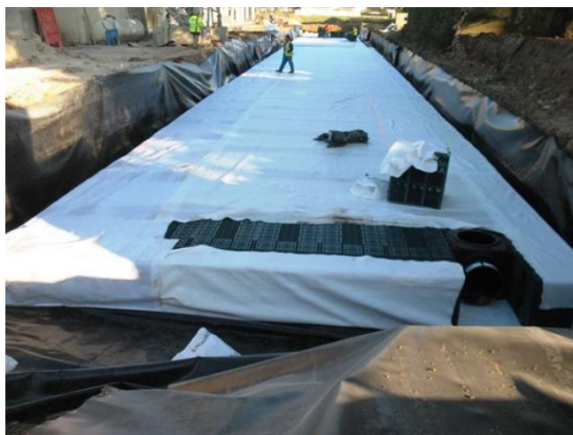
Figure 42 Mise en place de SAUL Source : Montmasson
