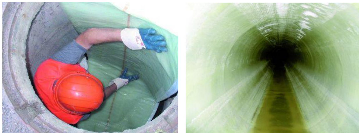
Figure 12 A gauche : introduction de la gaine, à droite : canalisation chemisée Source: Swietelsky-Faber GmbH Kanalsanierung 13
