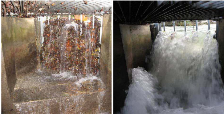
Figure 25 : Comparaison de la passe à poissons du pont de Serbie. A gauche la passe non entretenue et à droite la passe entretenue. (Source : CISALB, 2013)
