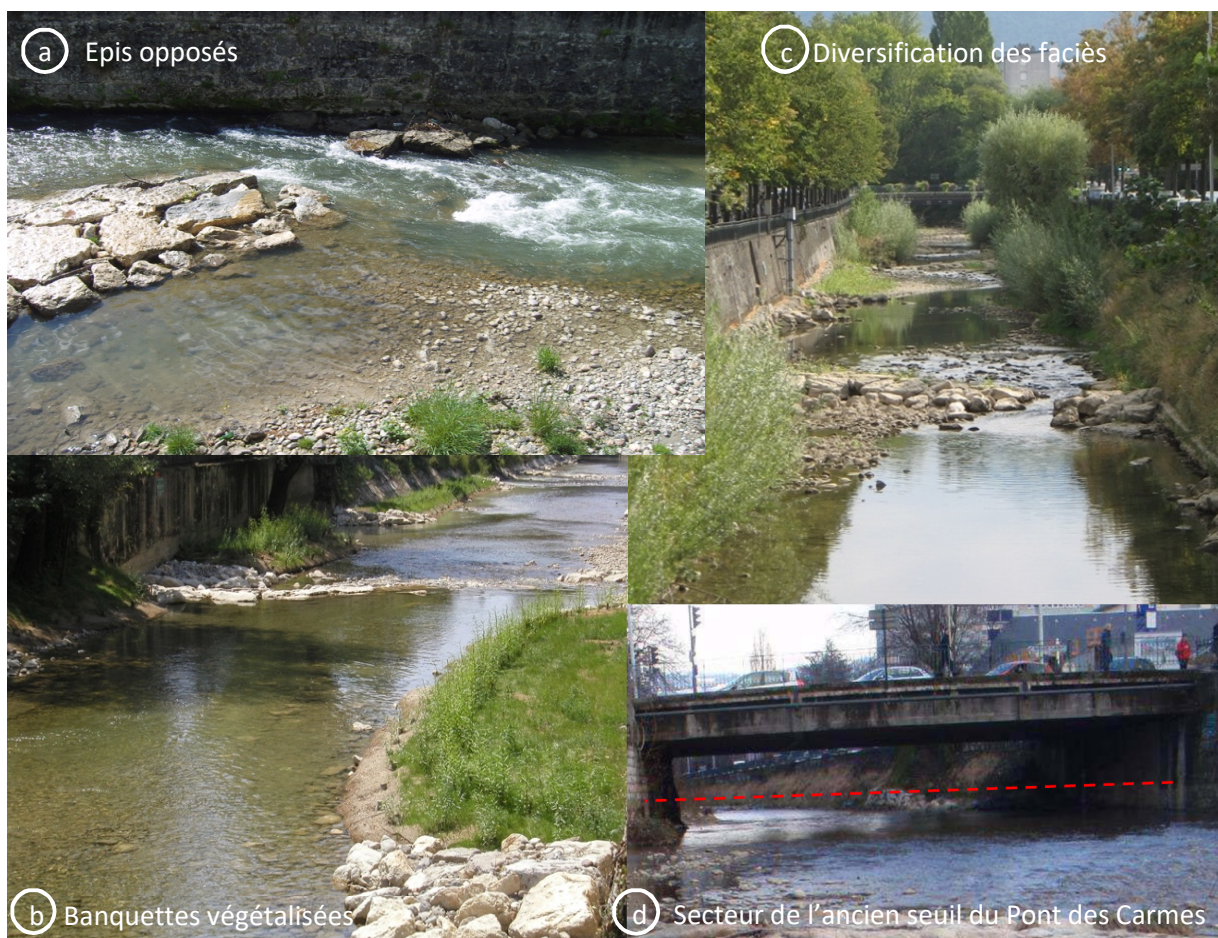
Figure 21 : Photographies des aménagements sur la Leysse (a) avec des épis opposés, (b) des banquettes végétalisées, (c) la diversification des faciès et (d) l'ancien seuil du Pont des Carmes. (Photos : CISALB)
