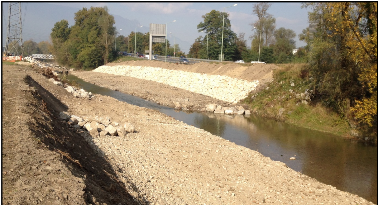
Figure 23 : Exemple de travaux 250 m sous la confluence Leysse Hyères (Source Csalb)
