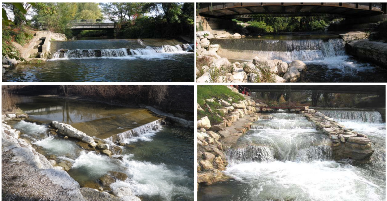
Figure 26 : Comparaison photographique avant/après les travaux du Sierroz (en haut 2007 et en bas 2014). A gauche le seuil du Pont Garibaldi et à droite le seuil du Pont SNCF. (Source : CISALB, 2007 et FSPDMA, 2014)
