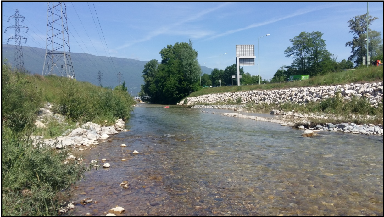
Figure 24 : Végétalisation du secteur après les travaux
