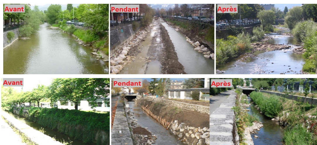
Figure 22 : Comparaison photographique avant/après les travaux de la Leysse (en haut) et de l'Albanne (en bas)(Source : Chambéry Métropole, 2016).
