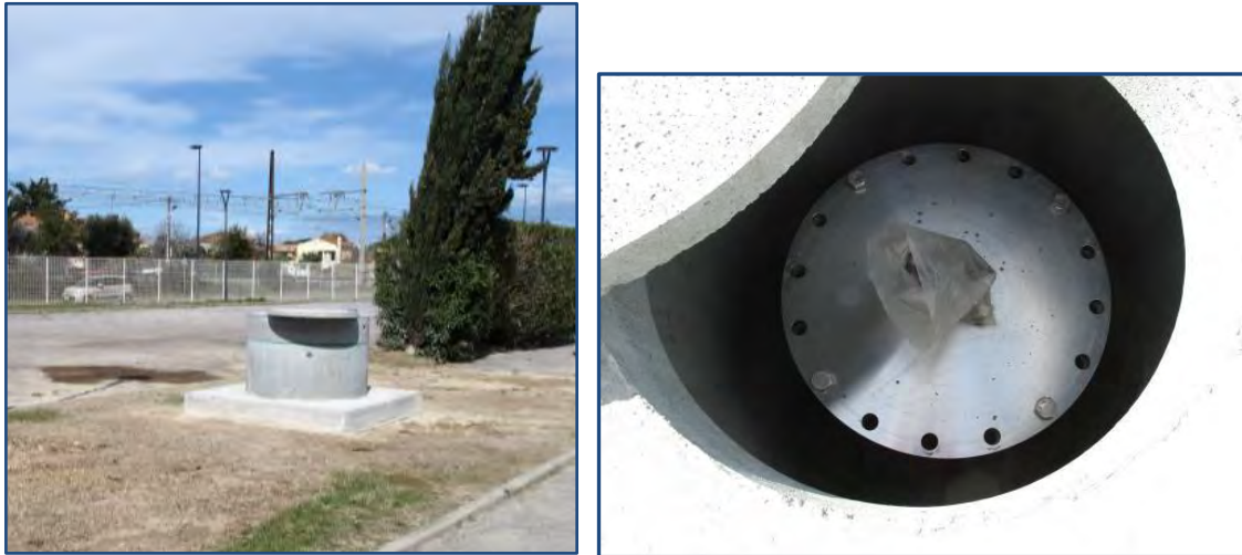
Illustration 6 : Margelle de protection et bride acier de la tête de forage « Stade Michel ».
