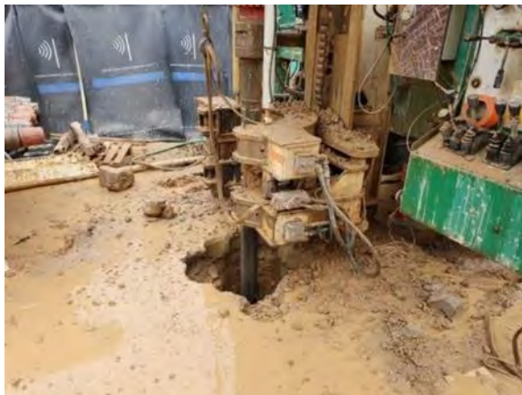
Figure A- 8 : Début foration du piézomètre superficiel (DEMT2)
