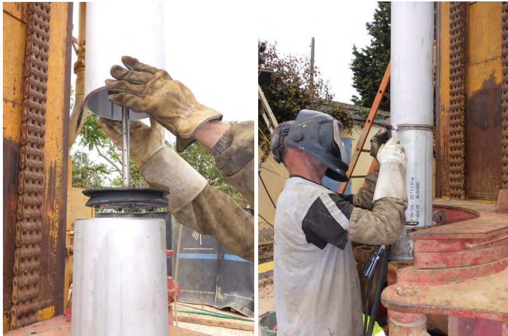
Figure A- 31: Dispositif d'inertage interne et soudure TIG des tubes inox
