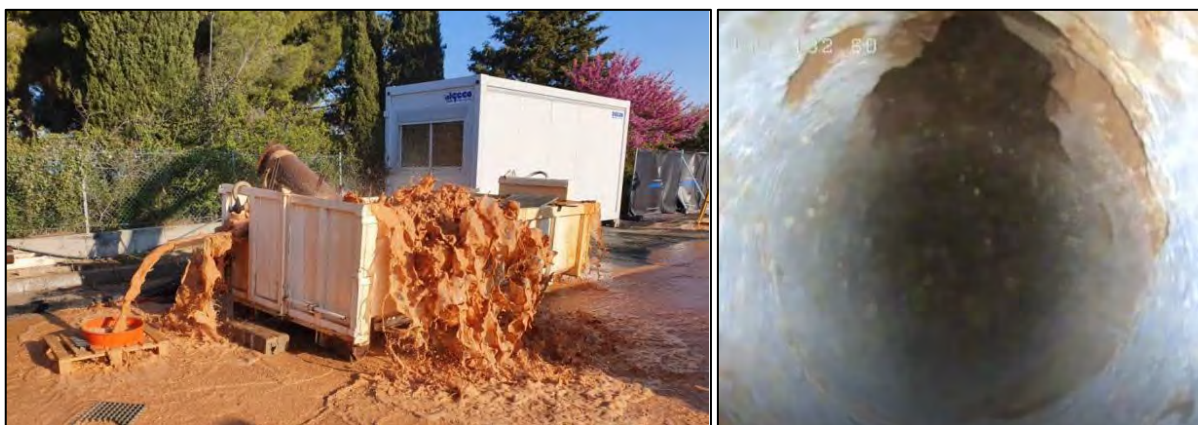
Figure A- 3: 132.5 m : Foration au PDC Ø 270 mm passage d'une fracture productrice d'eau très argileuse et vue de cette fracture lors de l'inspection vidéo
