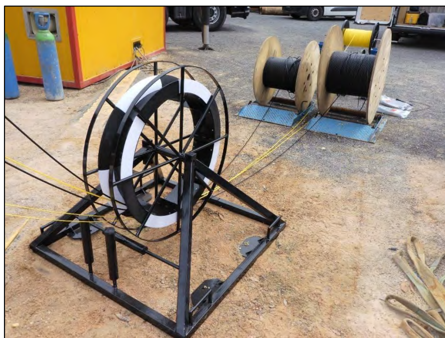
Figure A- 30 : Détail des déroulements des fibres optiques (Kloé)
