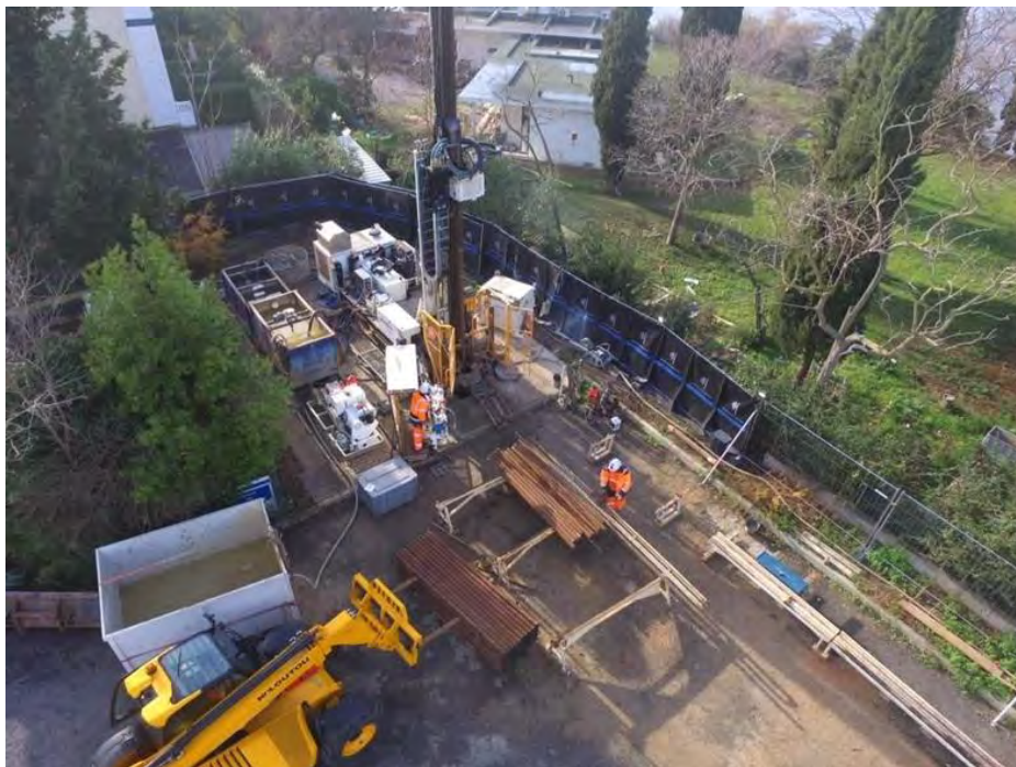
Figure A- 35 : Atelier de carottage LX11 de Géosonic
