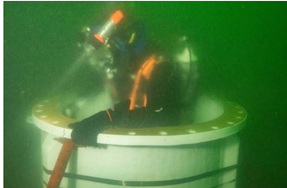
Illustration 7 : installation du nouveau collecteur
