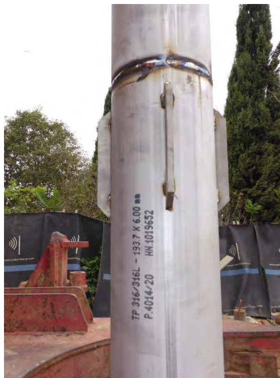
Figure A- 32 : vue des centreurs du tubage inox
