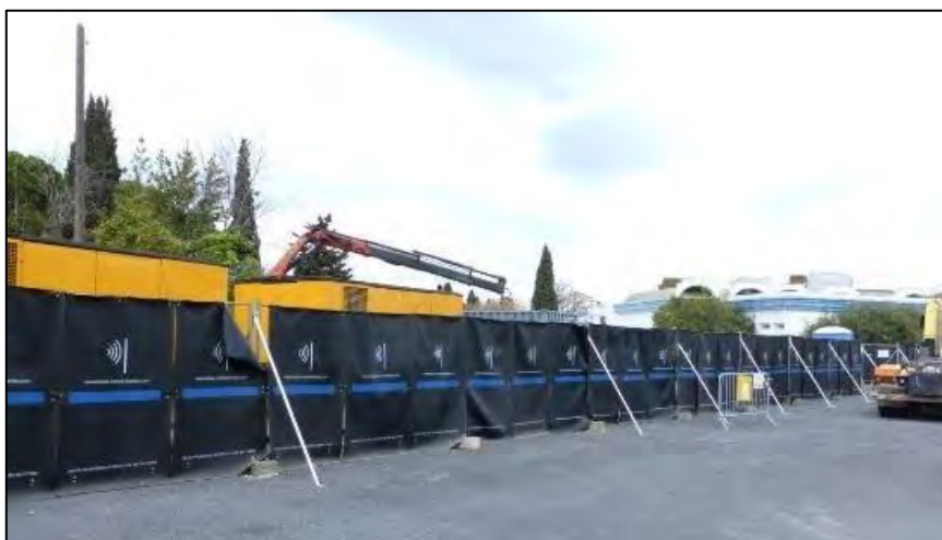
Figure A- 4: Protection du chantier avec des barrières scellées au sol du parking et habillées de bâche anti-bruit
