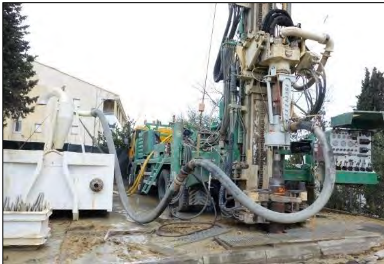
Figure A- 5: Bac de récupération des eaux de forage boueuses avec cyclonage et décantation
