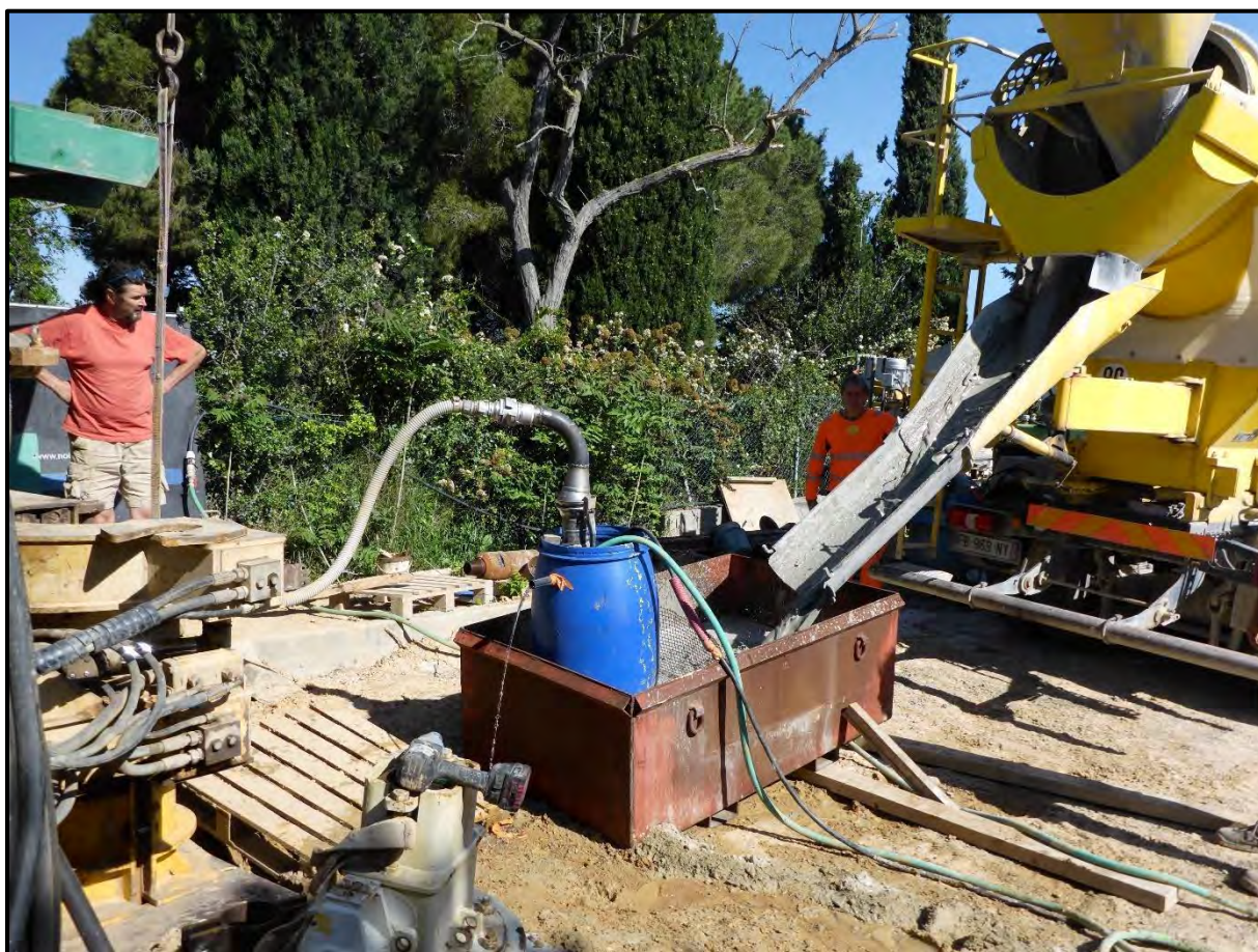
Figure A- 7: cimentation finale avec alimentation du coulis par toupie
