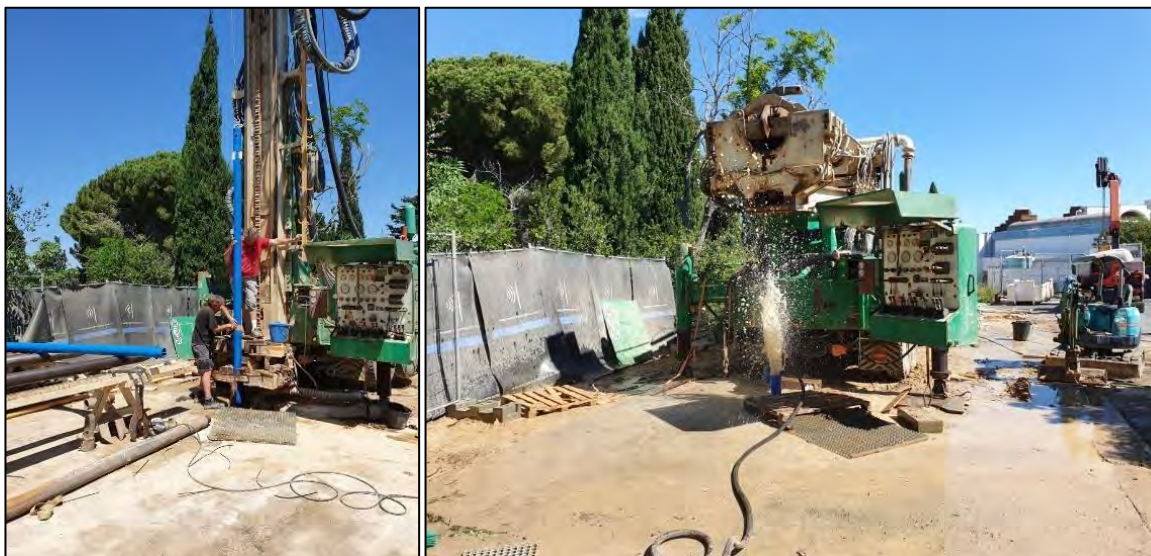
Figure A- 10 : Nettoyage du piézomètre superficiel
