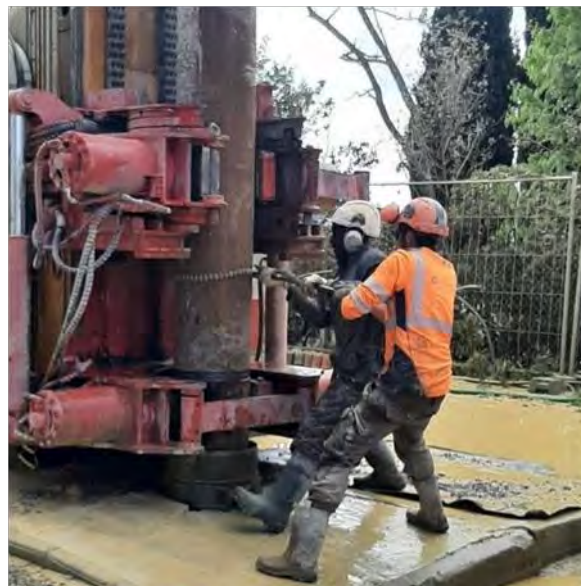
Figure A- 22 : Déblocage des tubages à l'avancement
