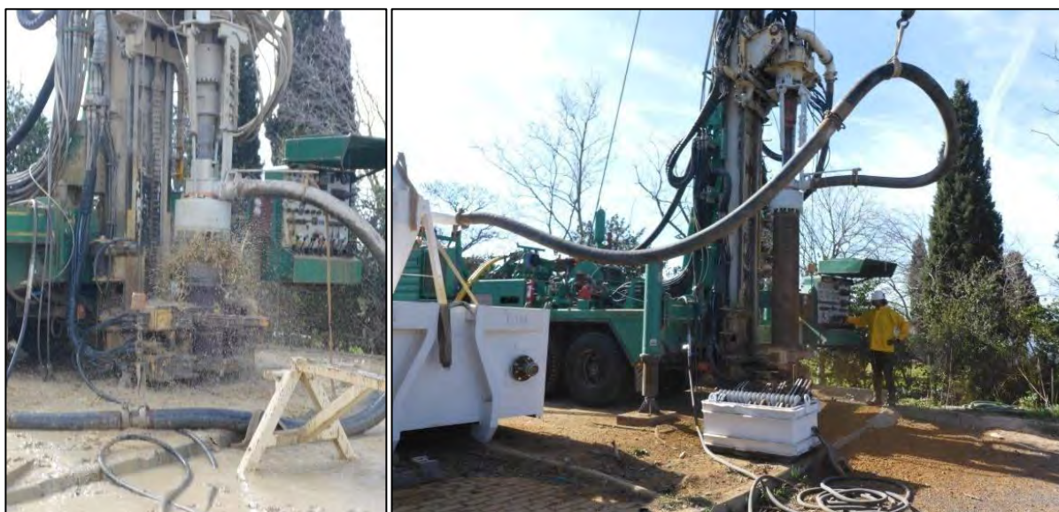
Figure A- 6 : Foration au MFT TAV Ø 323 mm
