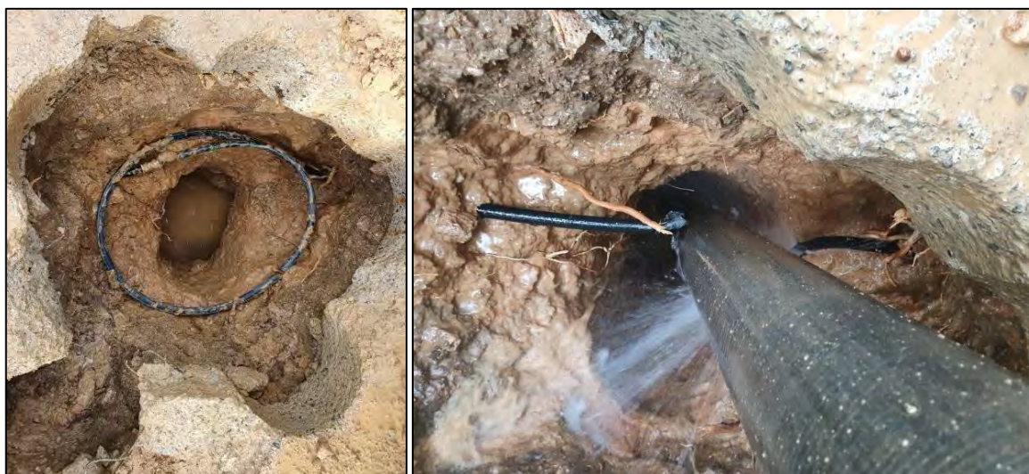
Figure A- 9 : Perforation d'un réseau lors de la foration du piézomètre superficiel (DEMT2)
