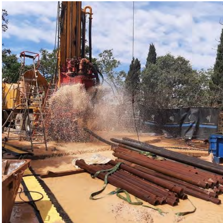
Figure A- 19 : Foration au MFT TAV Ø 323 mm
