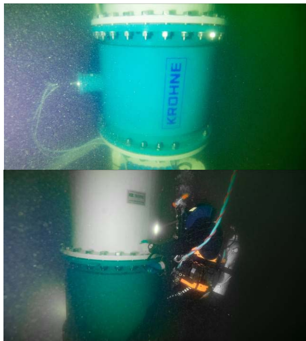
Illustration 10 : installation du débitmètre et de son collecteur
