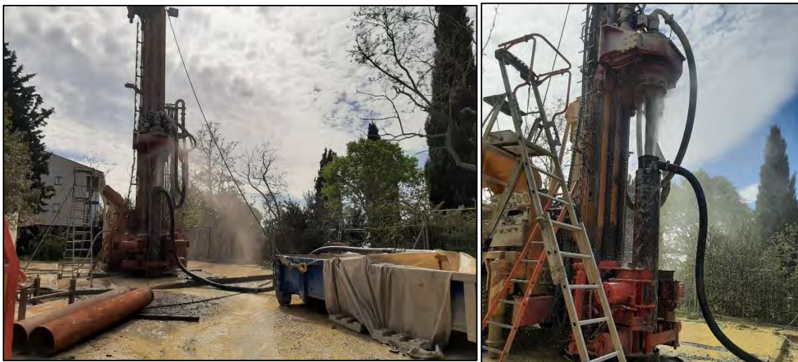
Figure A- 24 : Foration au MFT TAV Ø 323 mm
