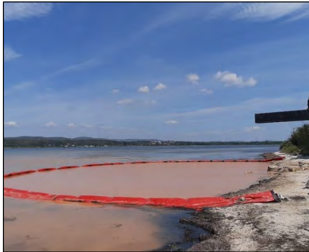
Figure A- 23 : Barrage anti-turbidité au droit du point de rejet
