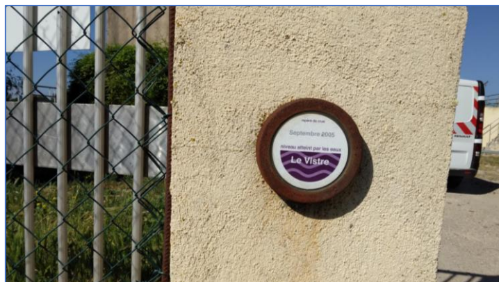
Repère de la crue de 2005 sur l'entrée de la STEP
