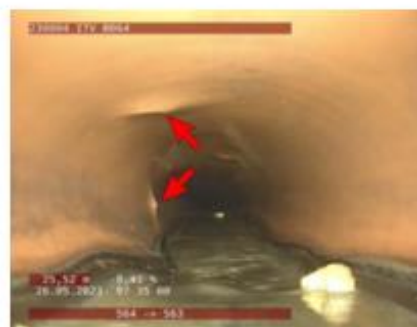
F : Réduction de section / Poinçonnement
